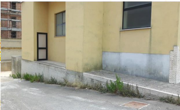
Foto 7 – prospetto Nord - umidità
