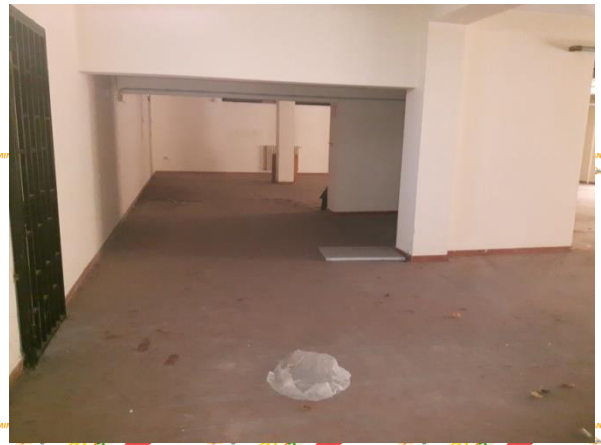
Foto 10 - Vano ribassato sottoscala
