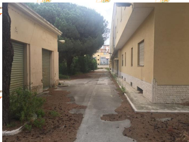
Foto 2 - Vista della strada sul prospetto Ovest
