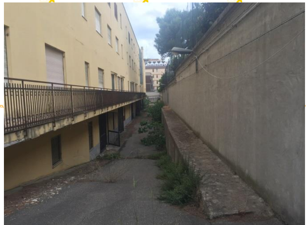
Foto 10 – Prospetto Est, ballatoio esterno
