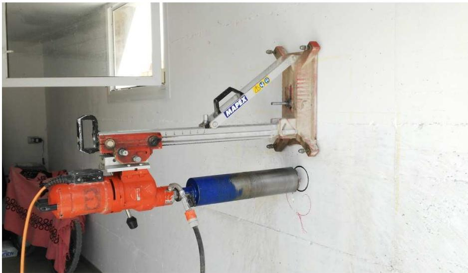
**Foto 02.** *Strumento utilizzato per il carotaggio.*
