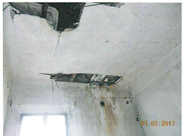
Particolare cedimento solaio sottotetto
