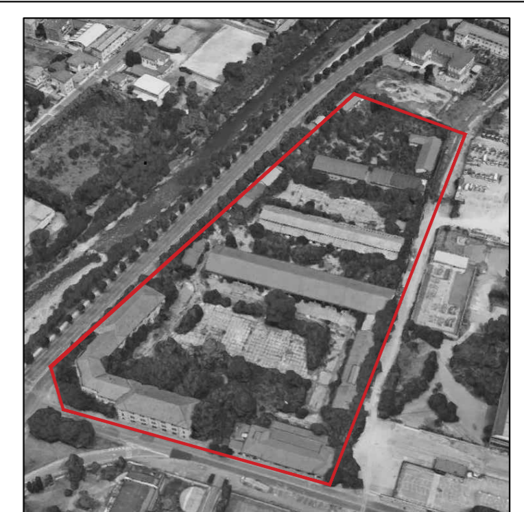
Piano Attuativo - Censimento di proprietà dello Stato denominato "ex Caserma Papa", sito in Brescia, Via Franchi/Via Oberdan
