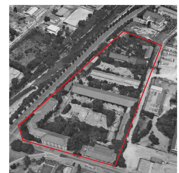
Piano Attuativo - Compendio di proprietà dello Stato denominato "ex Caserma Papa", sito in Brescia, Via Franchi/Via Oberdan
