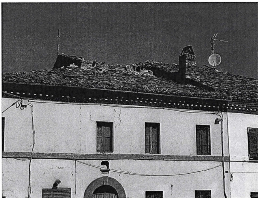
Foto 1. Vista del tetto fronte Strada Contrada Bore
