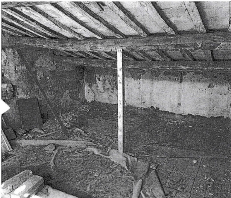
Foto 4. Vista sulla porzione rimanente di copertura
