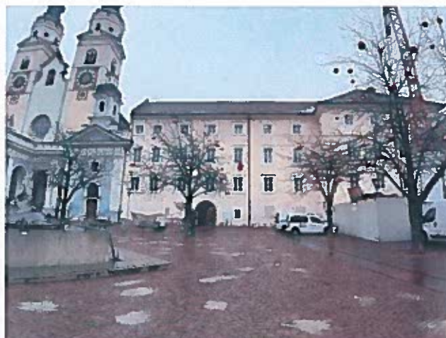
Foto 2: Vista sulla piazza pubblica e su facciata dell'edificio in oggetto
