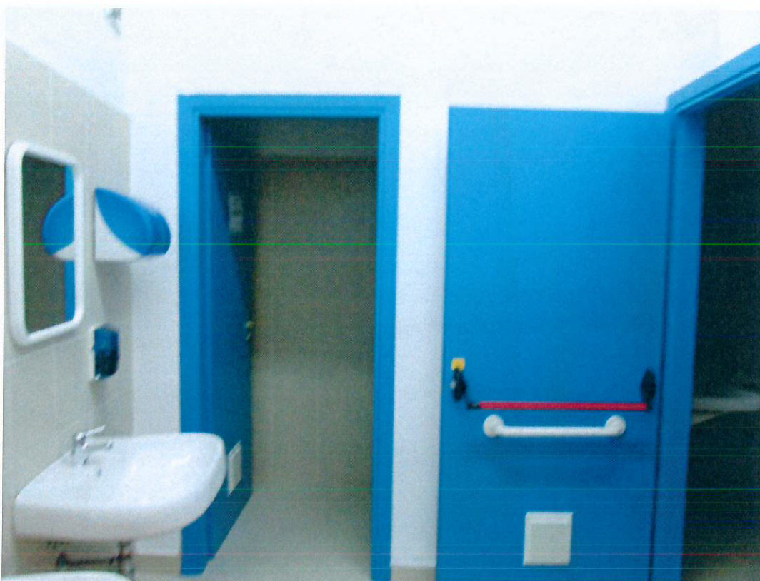
Foto 15 - bagno piano terra
