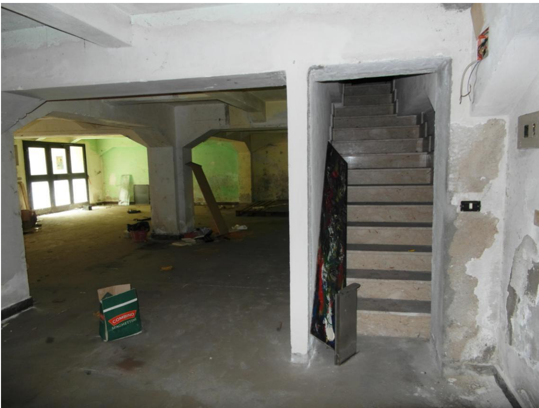
Fig. 5. Il seminterrato dell'edificio.
