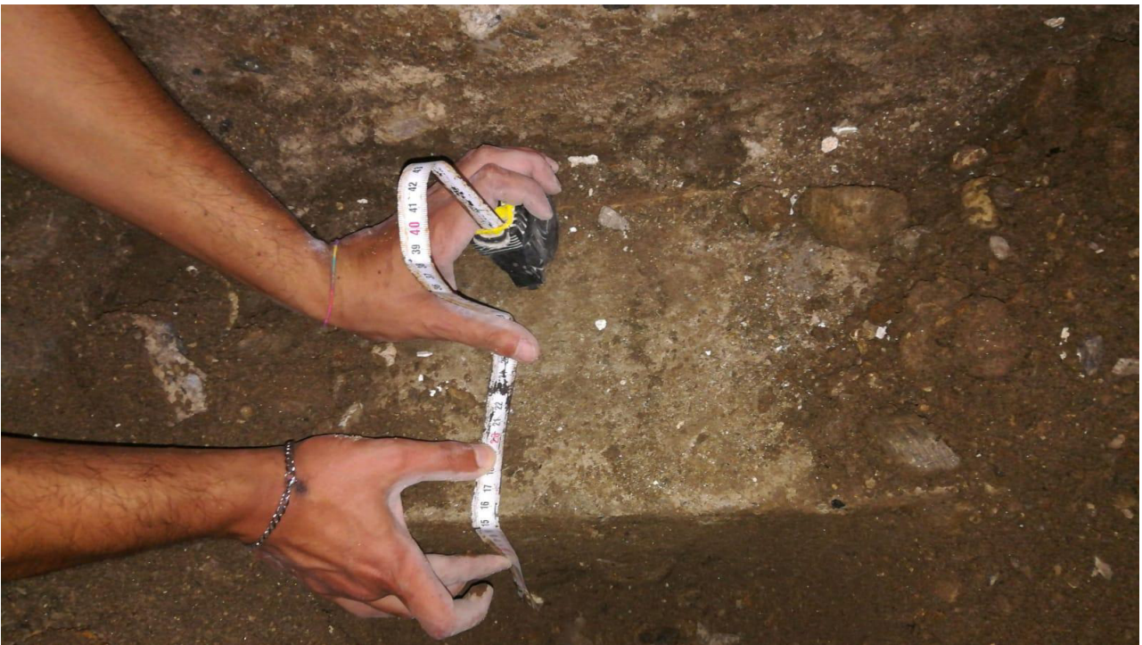
Fig. 8. Particolare della fondazione dell'edificio; in primo piano la trave rovescia.
