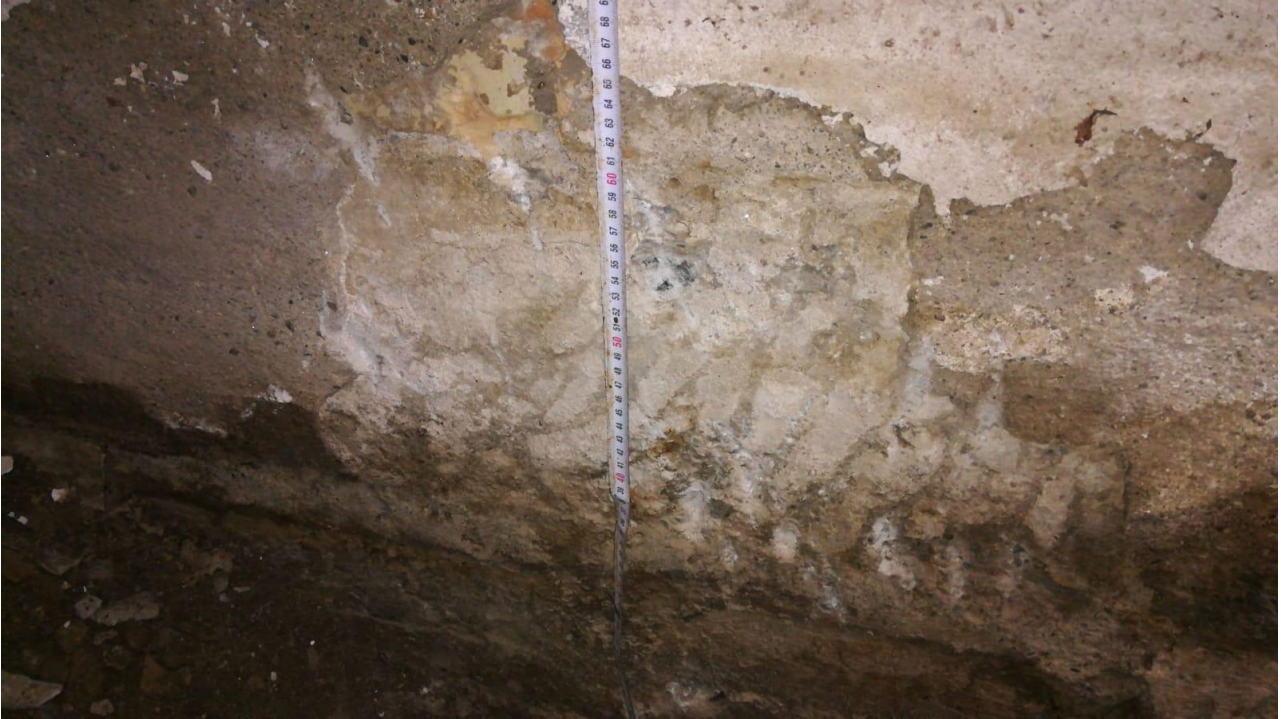
Fig. 7. L'area in corso di scavo; in primo piano, la fondazione del muro perimetrale est dell'edificio.
