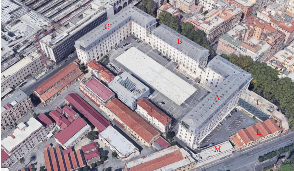
Foto con identificazione edifici.
