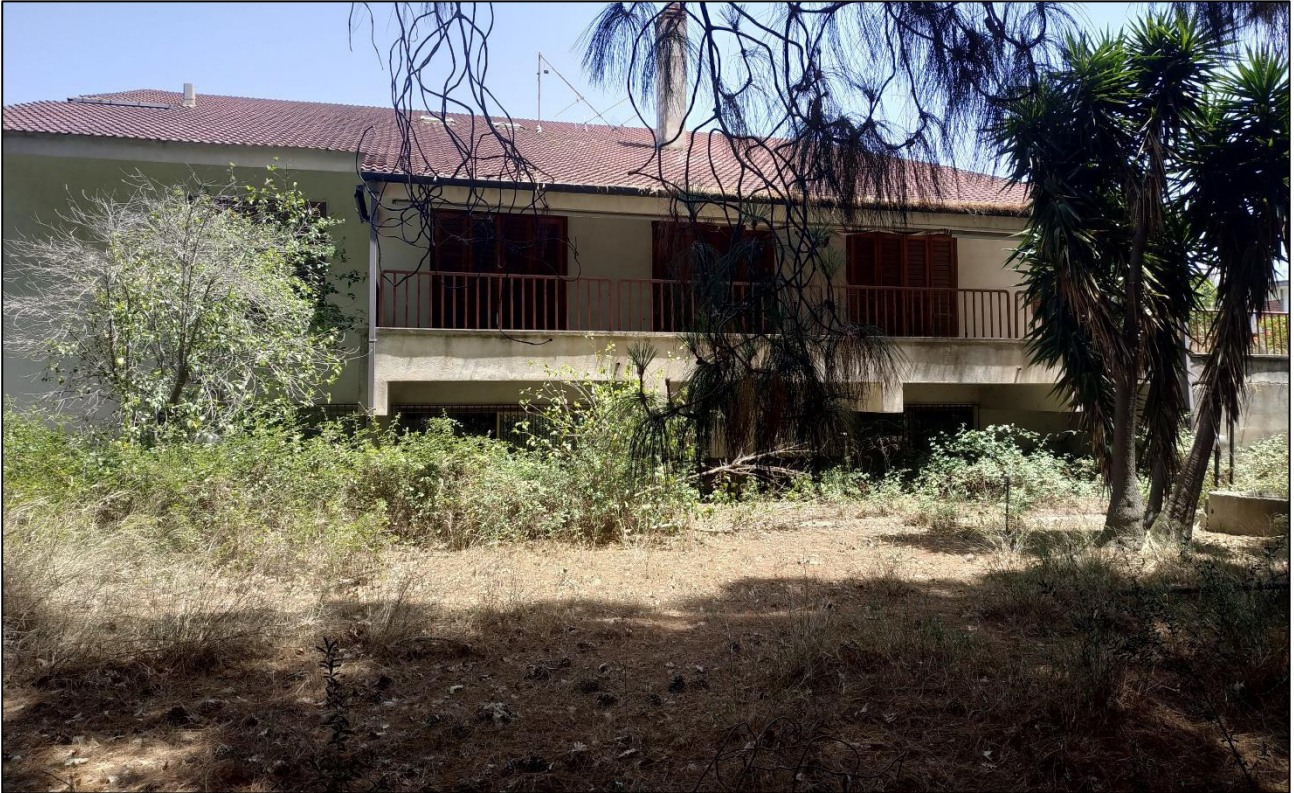
Figura 2-1 - Veduta esterna del prospetto Nord-Est
