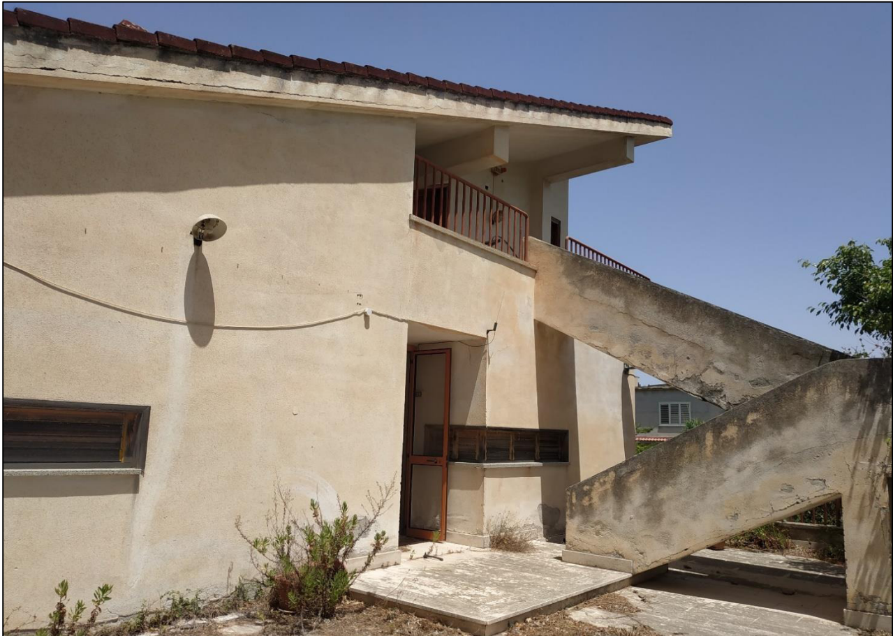
Figura 2-4 - Prospetto Nord - Ingresso
