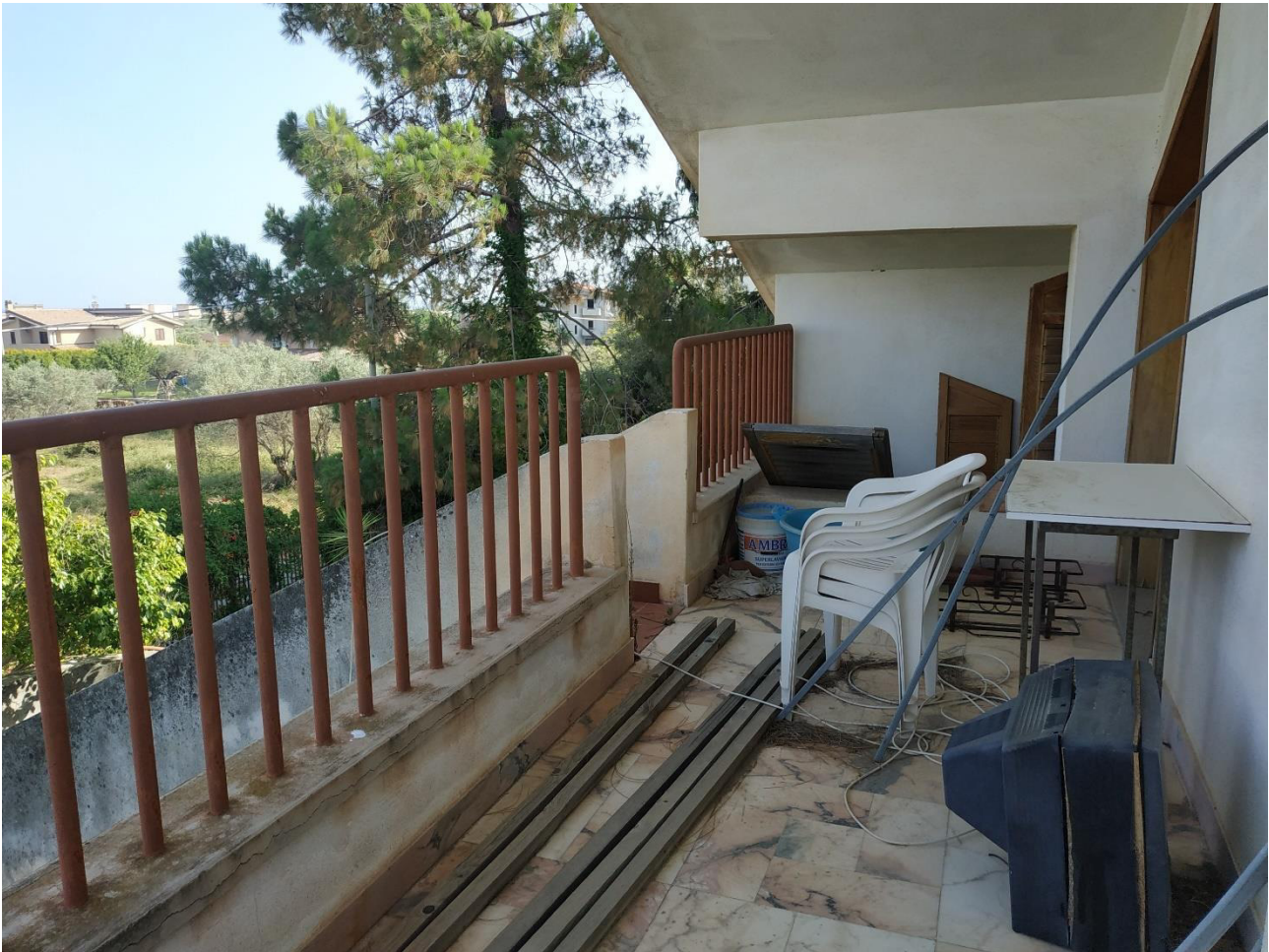
Figura 28 – Ingresso terrazzo piano primo
