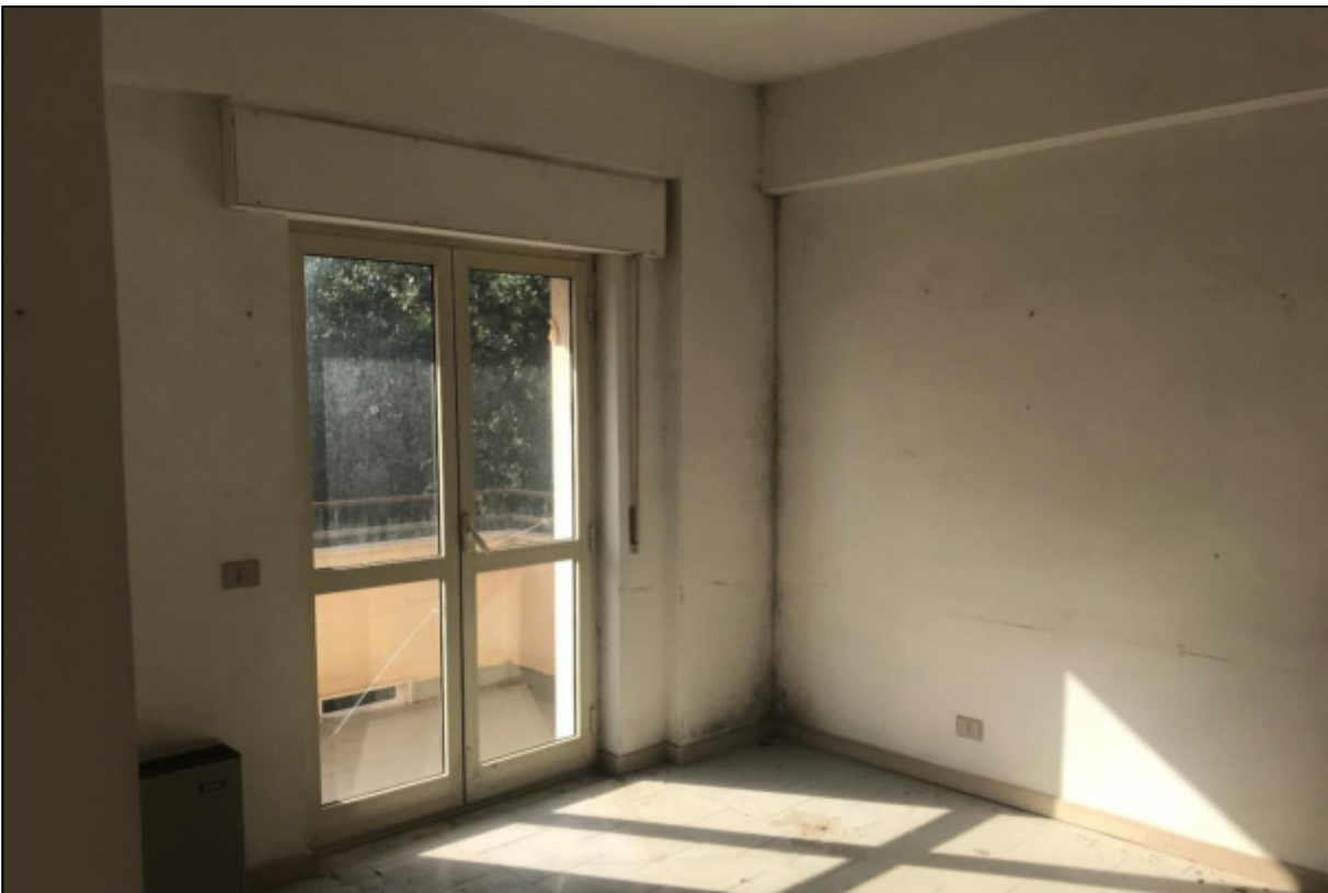
Figura 61- Interno appartamento con vista del balcone
