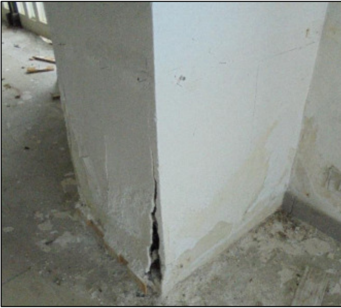
Figura 15 - Distacco d'intonaco
