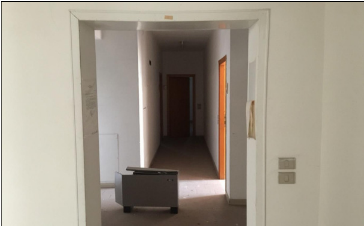
Figura 77 – Corridoio interno di collegamento
