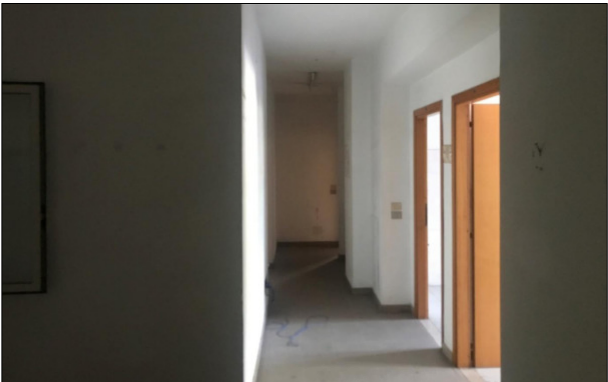
Figura 31 - Corridoio interno di collegamento
