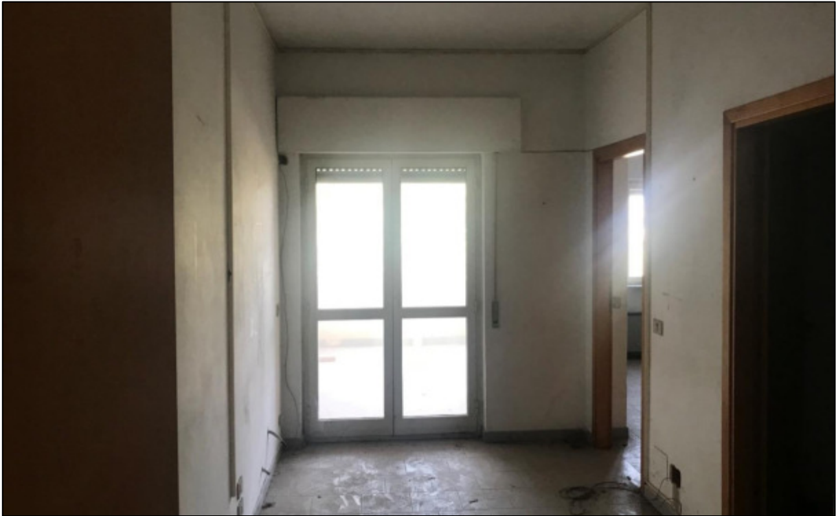
Figura 38 - Interno appartamento con vista del balcone
