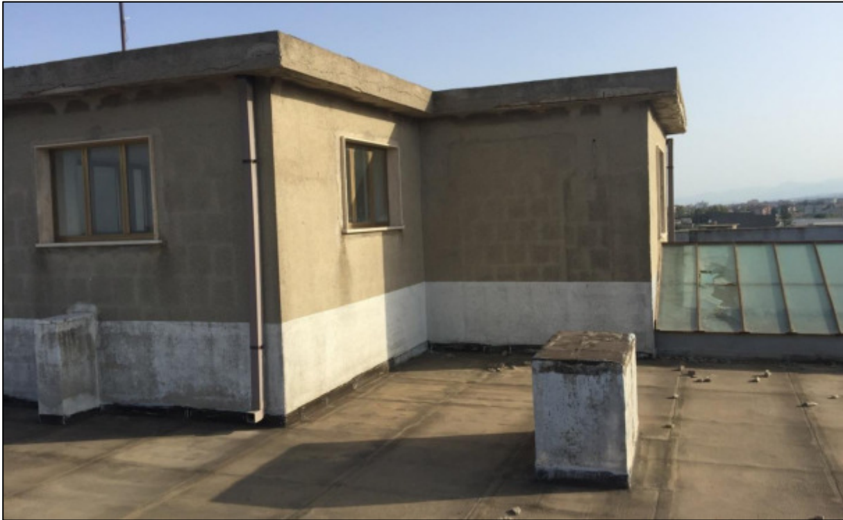
Figura 90 – Copertura e lucernario
