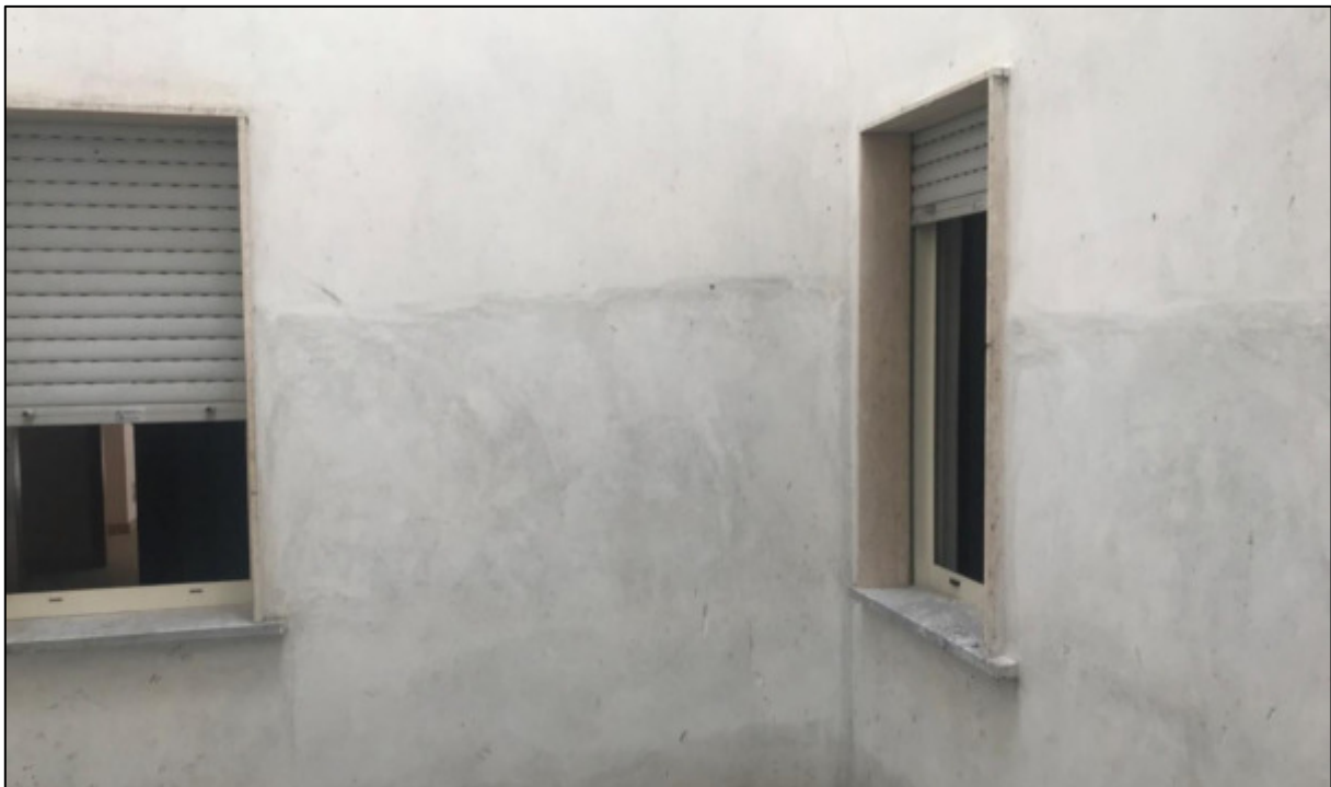
Figura 23 - Pozzo di luce
