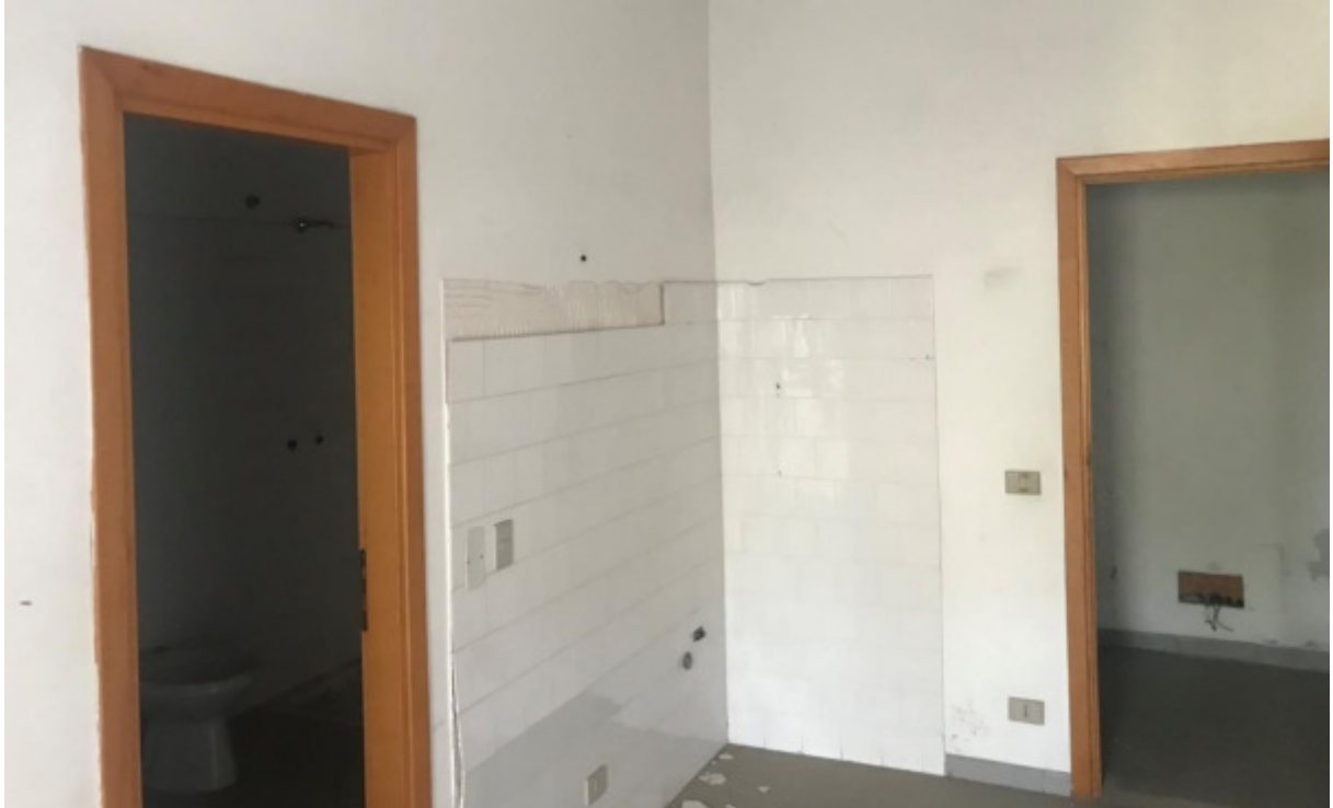
Figura 39 - Interno appartamento con vista angolo cottura
