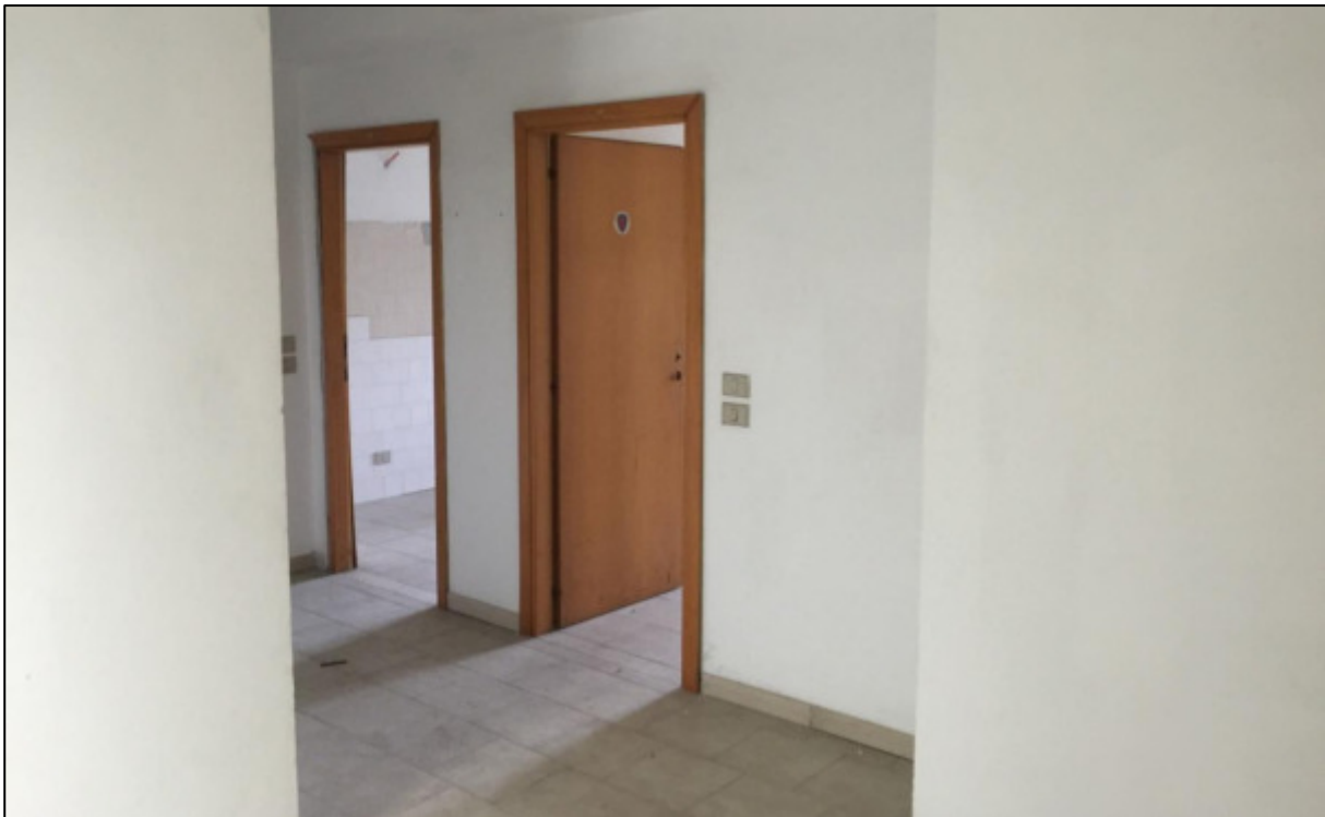
Figura 63 – Corridoio interno di collegamento
