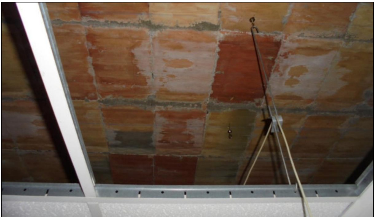
Figura 12 - Attacco controsoffitto al solaio
