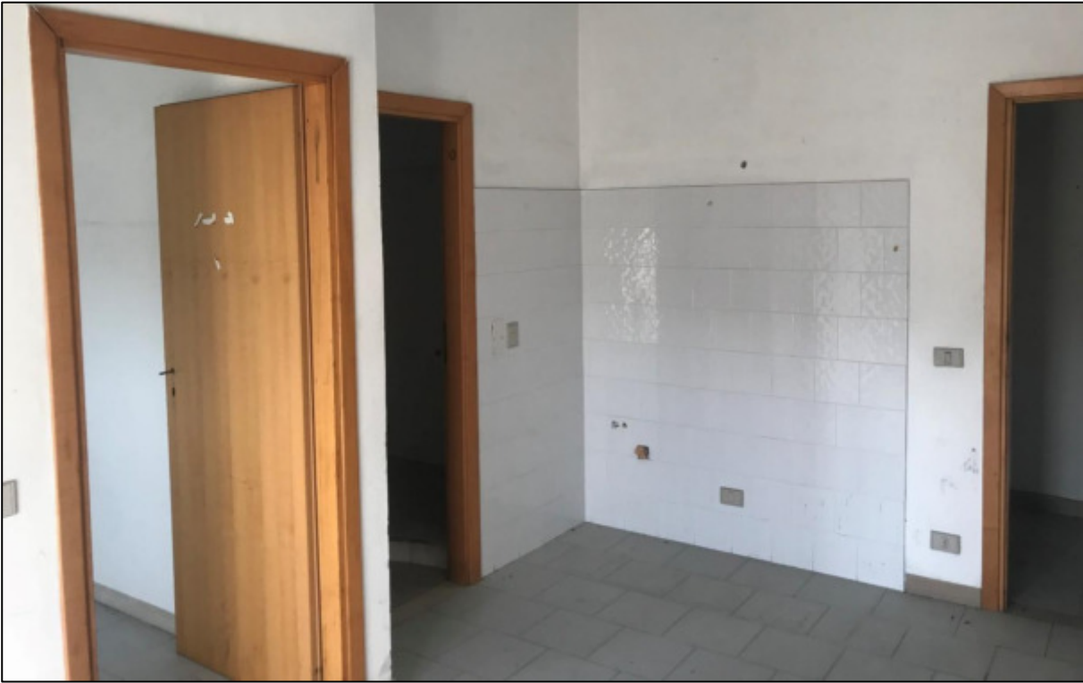
Figura 58 - Interno appartamento con vista angolo cottura
