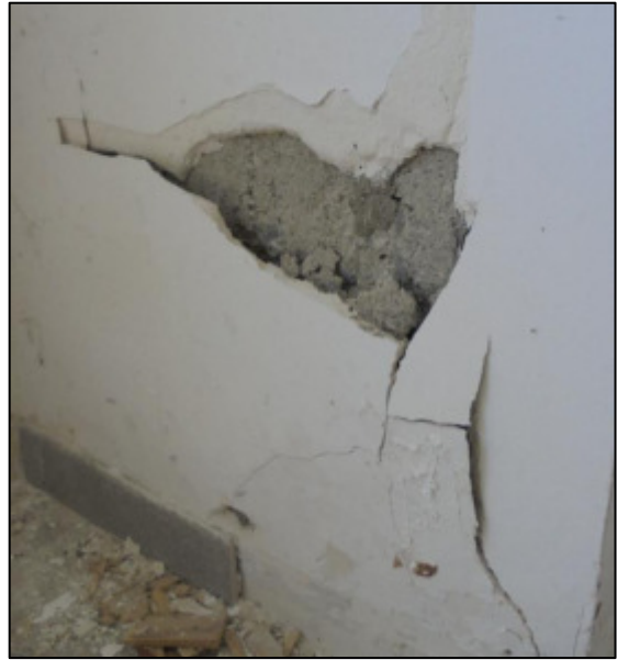
Figura 16 - Distacco d'intonaco
