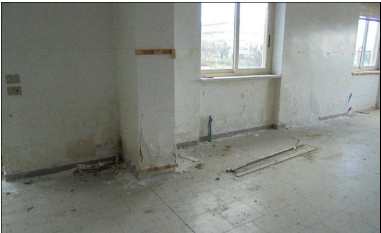
Figura 14 - Distacco d'intonaco
