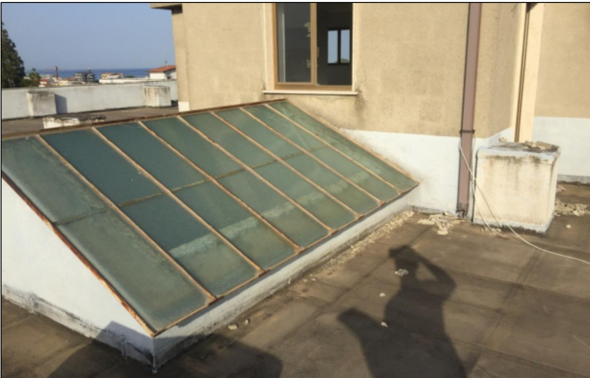
Figura 89 – Copertura e lucernario
