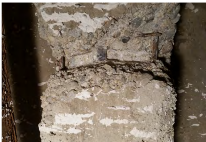
Rilievo delle armature
