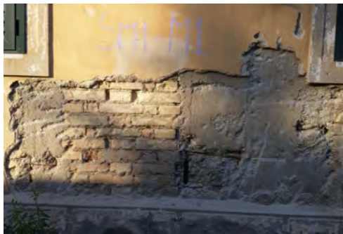
Ubicazione saggio e tipologia muraria
