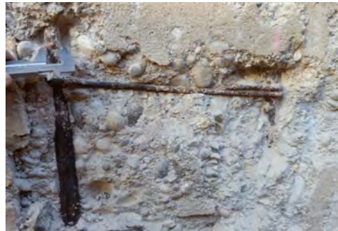
Rilievo armatura dei pilastri
