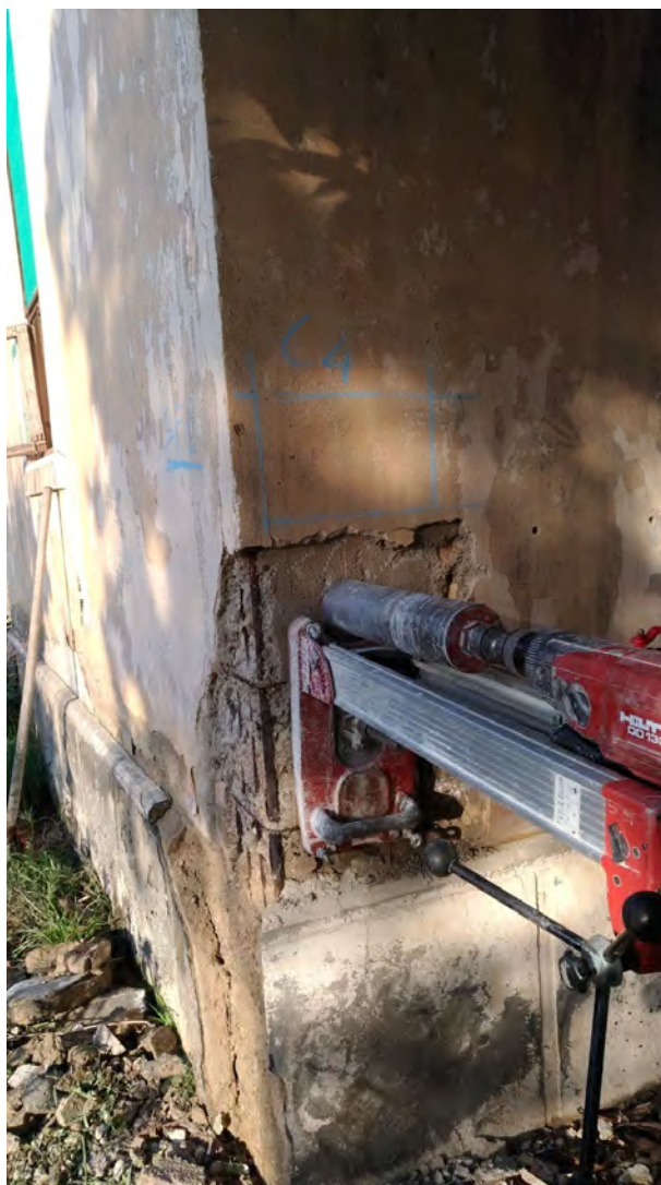
(Postazione di carotaggio ed attrezzatura utilizzata)
