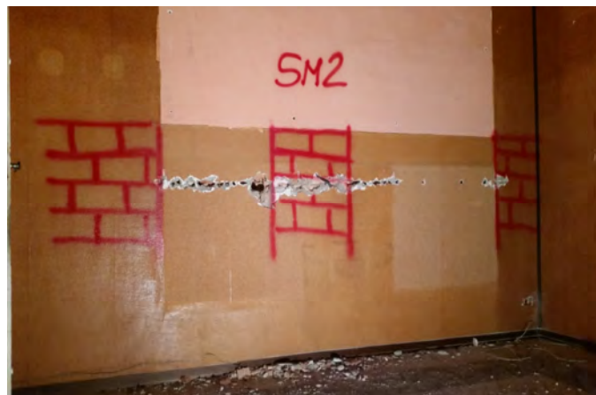
Ubicazione saggio e tipologia muraria
