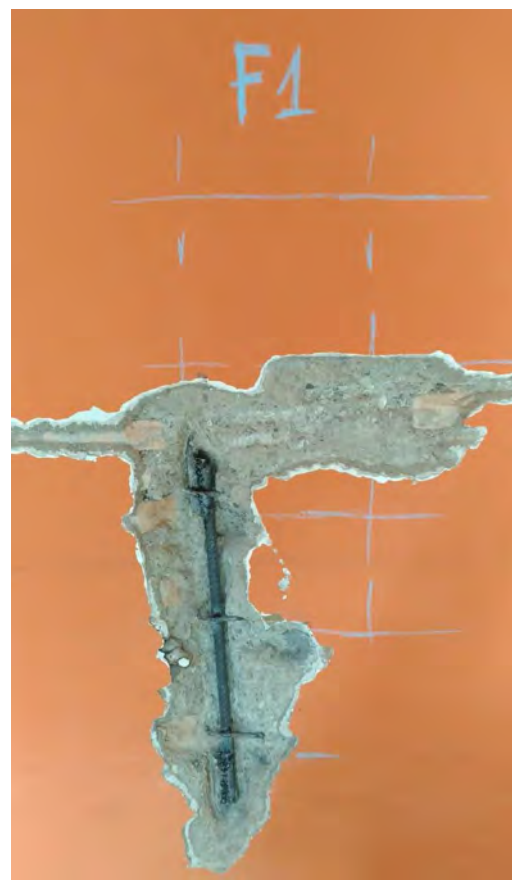
Ripristino della barra d'armatura
