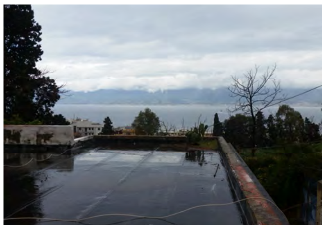
Estradosso solaio a terrazzo
