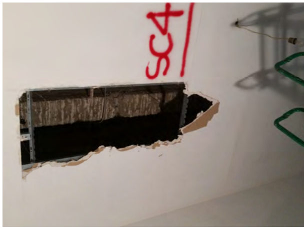
Ubicazione saggio armatura
