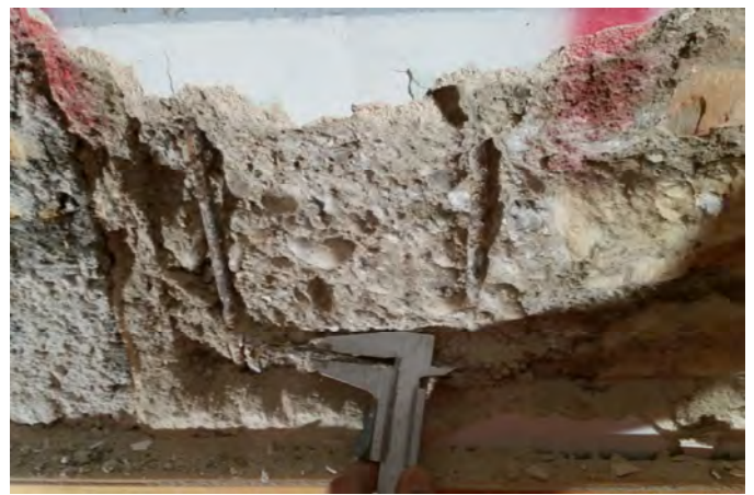
Rilievo armatura del pilastrino in calcestruzzo
