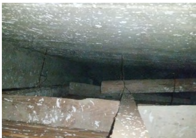
Controsoffittatura ancorata direttamente all'armatura del solaio
