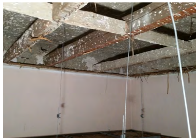
Solaio gettato in opera
