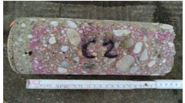
Profondità di carbonatazione
