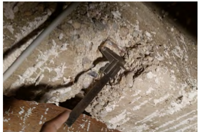
Rilievo delle armature
