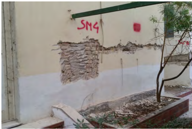
Ubicazione saggio e tipologia muraria
