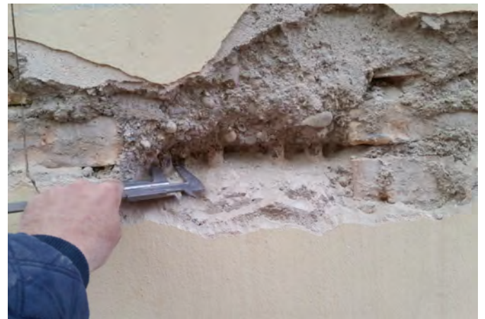
Rilievo armatura del pilastro in calcestruzzo
