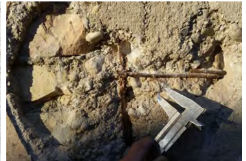
Rilievo armatura dei pilastri
