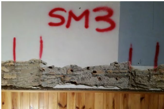
Ubicazione saggio e tipologia muraria
