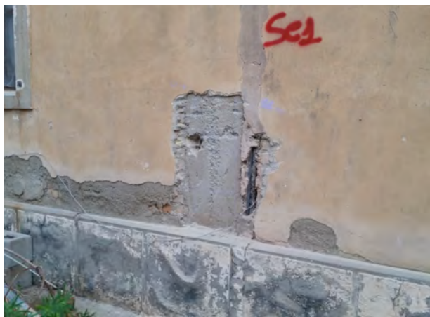
Ubicazione saggio armatura
