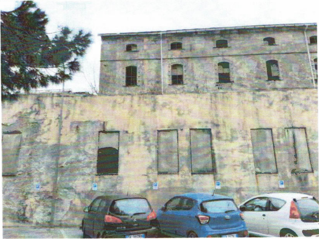
Fig. 12 – Vista prospetto corpo D lato Nord-Est
