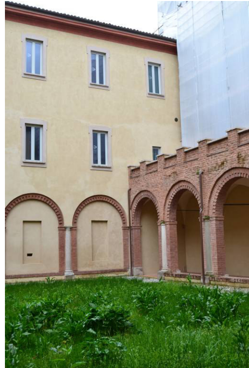
Vista del loggiato del chiostro A che conduce all'androne.
