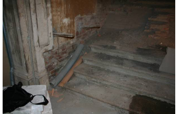
Foto dei n.4 gradini ancora esistenti
