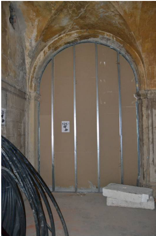
Vista interna del varco di accesso al chiostro A, attualmente tamponato
