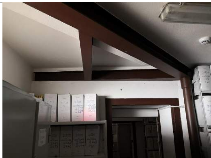
Area archivi seminterrato
