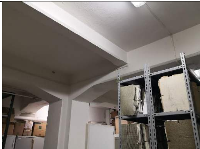
Area archivi seminterrato
