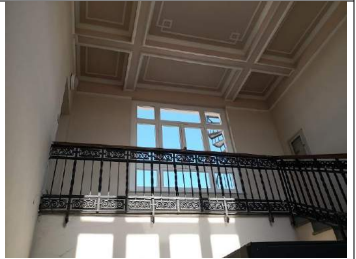
Copertura del vano scala
