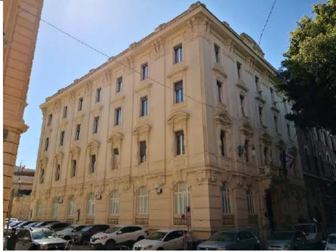
Vista esterna del fabbricato
