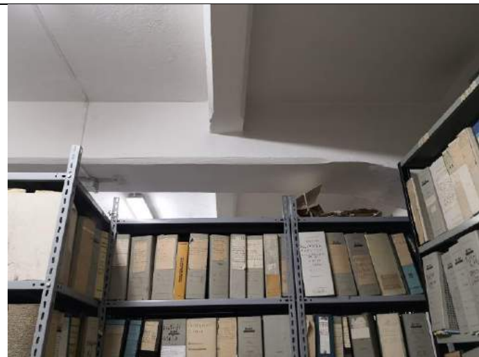
Area archivi seminterrato
