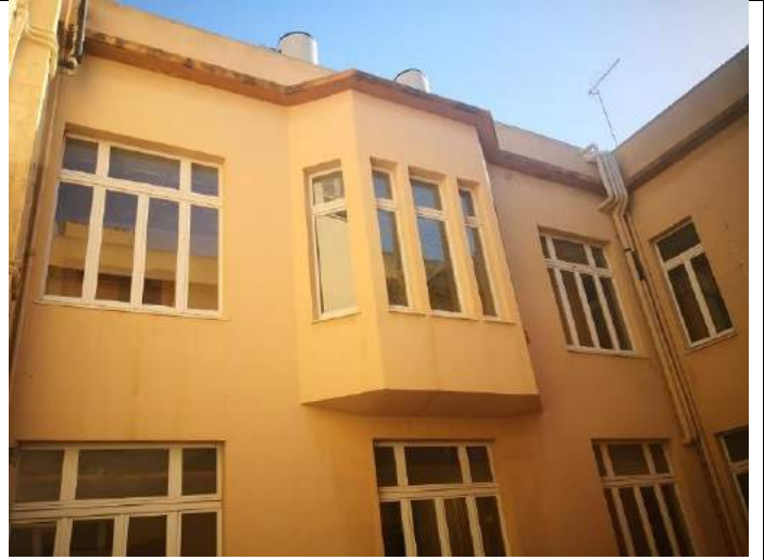
Dettaglio del prospetto interno al pozzo luce
