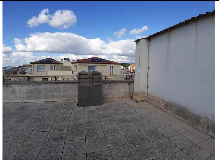
Vista esterna Palazzina residenza
