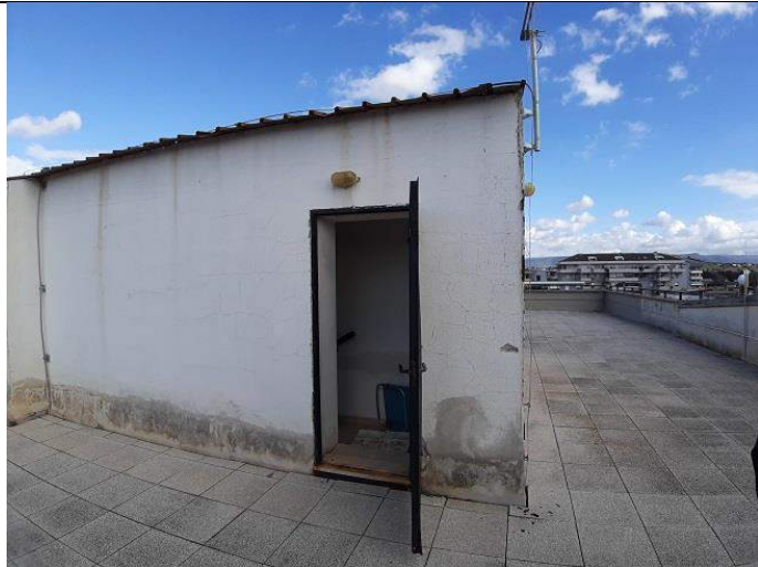
Vista esterna Palazzina residenza
