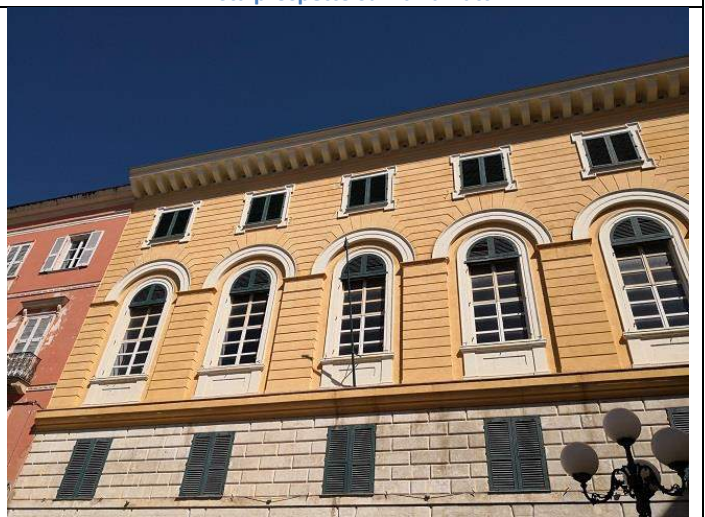
Vista prospetto su piazza Asuni
