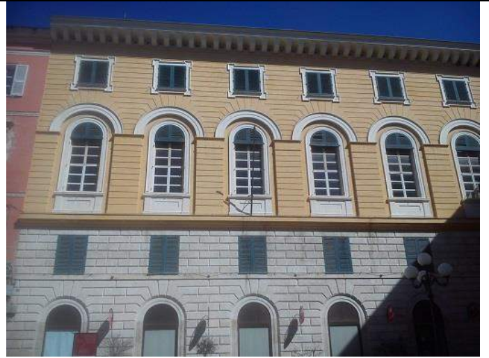
Vista prospetto su piazza Asuni
