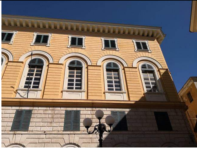
Vista prospetto su piazza Asuni
