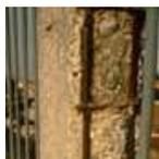
La carbonatazione provoca la corrosione dei ferri d'armatura quando la struttura è prevalentemente esposta all'aria, all'acqua e all'ossigeno. Le strutture interessate sono quelle relative agli interni degli edifici, civili o industriali, all'esterno e a contatto con acqua e o terreni non aggressivi.
