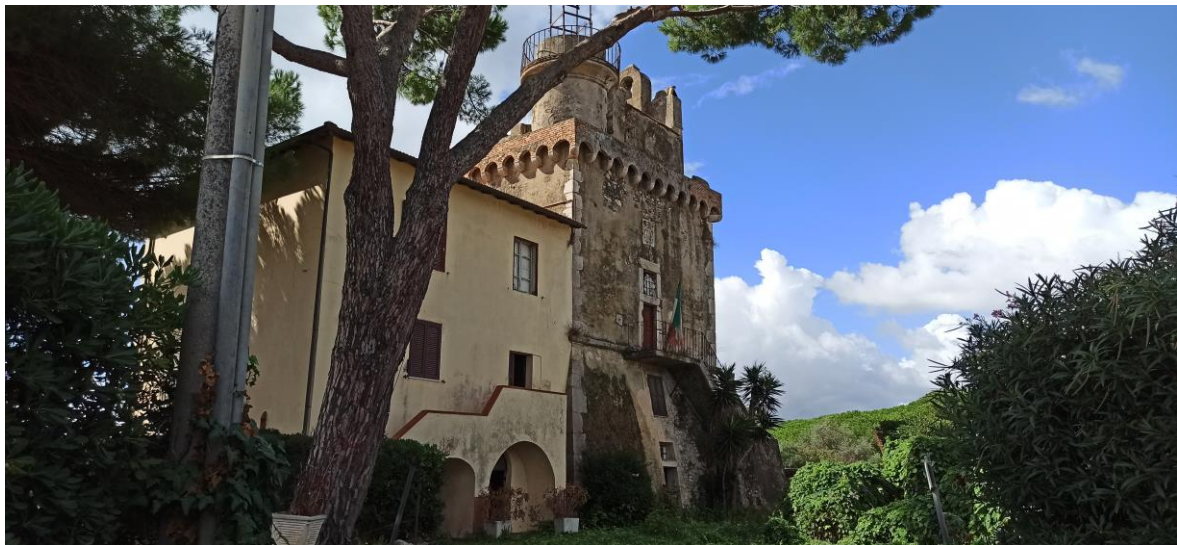
Esterno e fronte principale del complesso edilizio
