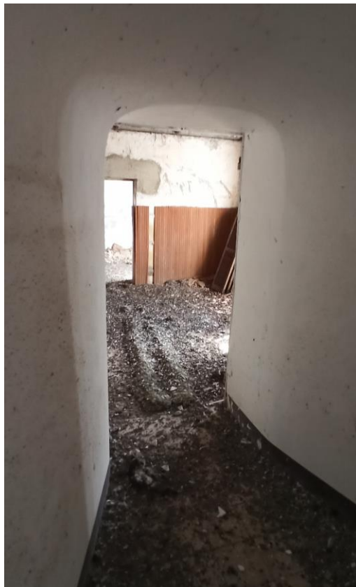
Torre: varco di comunicazione con il secondo piano del fabbricato adiacente
