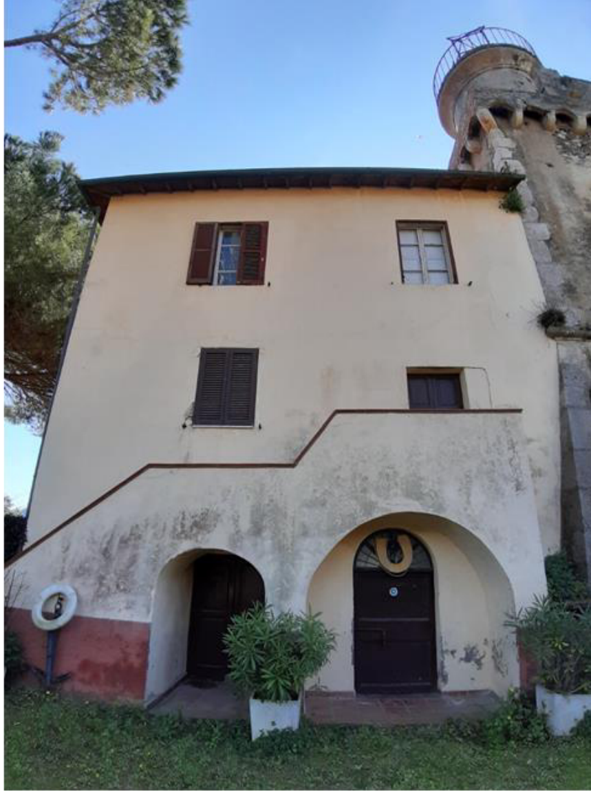
Ingresso e della scala esterna del fabbricato adiacente
