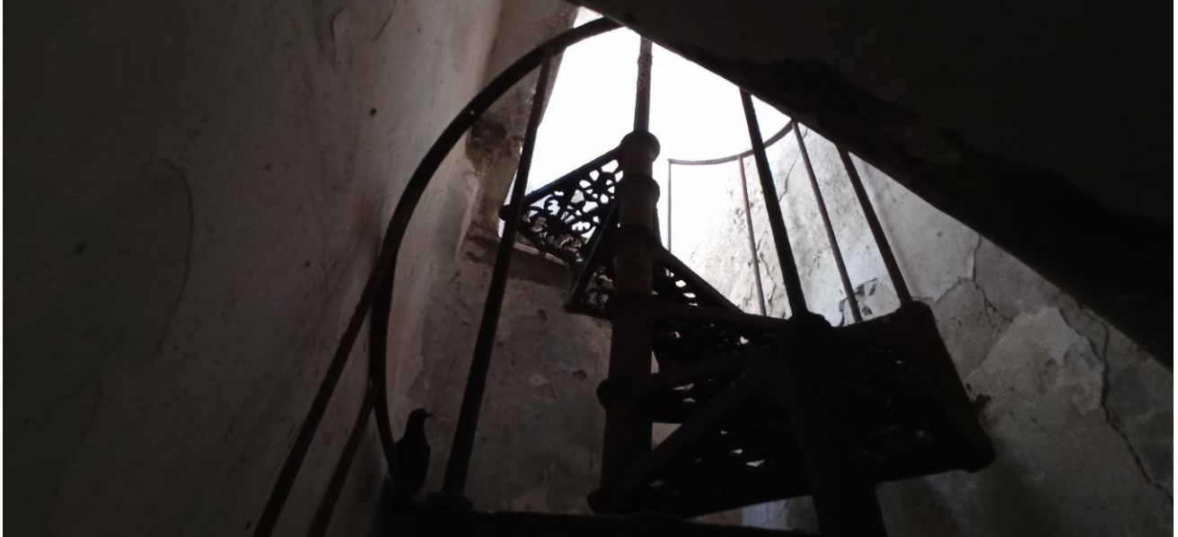
Torre: scala in metallo per salire alla piazza d'armi
