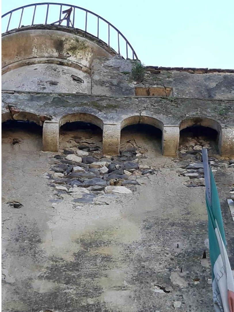
Particolare del coronamento
