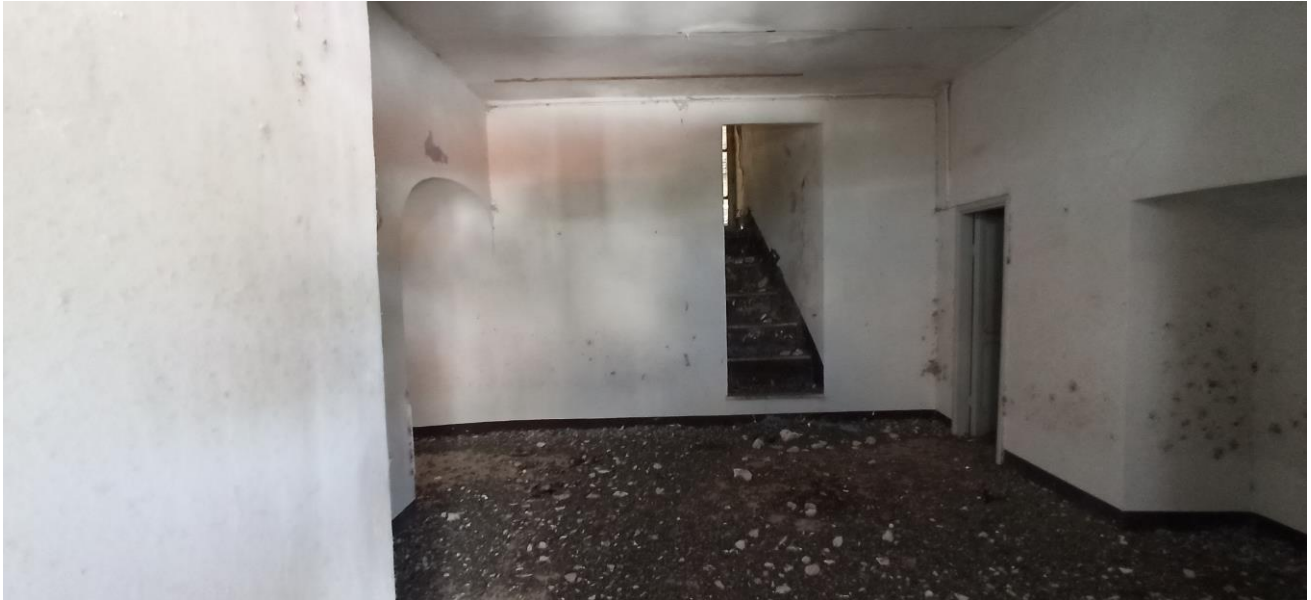
Torre: locali del primo piano
