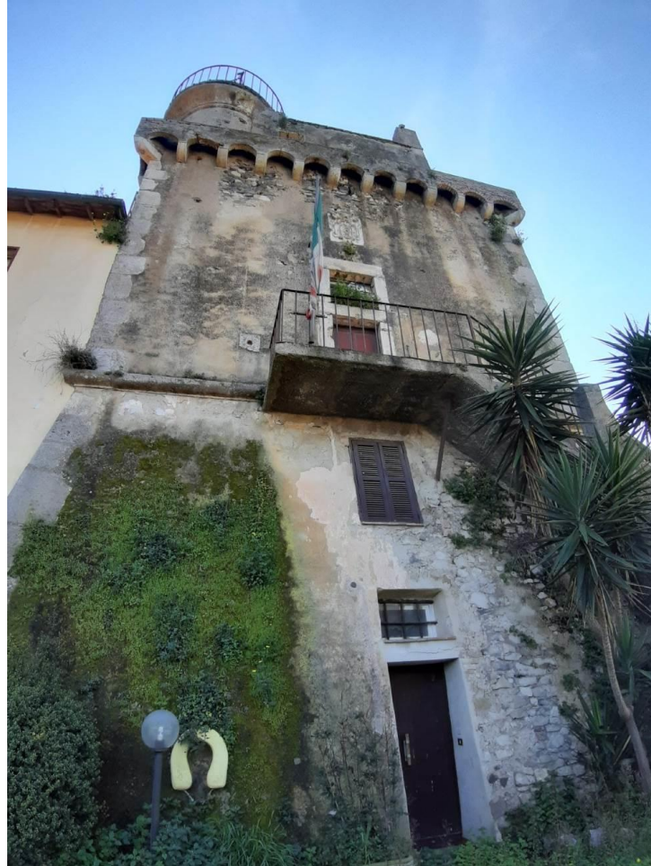
Facciata principale della Torre, con accesso al piano terra e primo. In alto lo stemma dei Borghese
