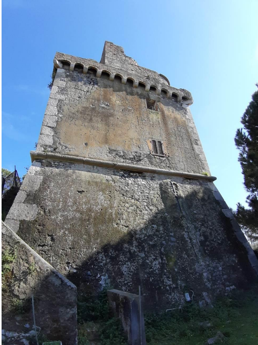
Facciata laterale con sbarco della scala esterna di accesso
