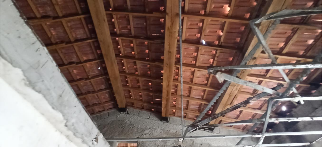
Fabbricato adiacente: particolare del solaio in legno al secondo piano, recentemente ricostruito
