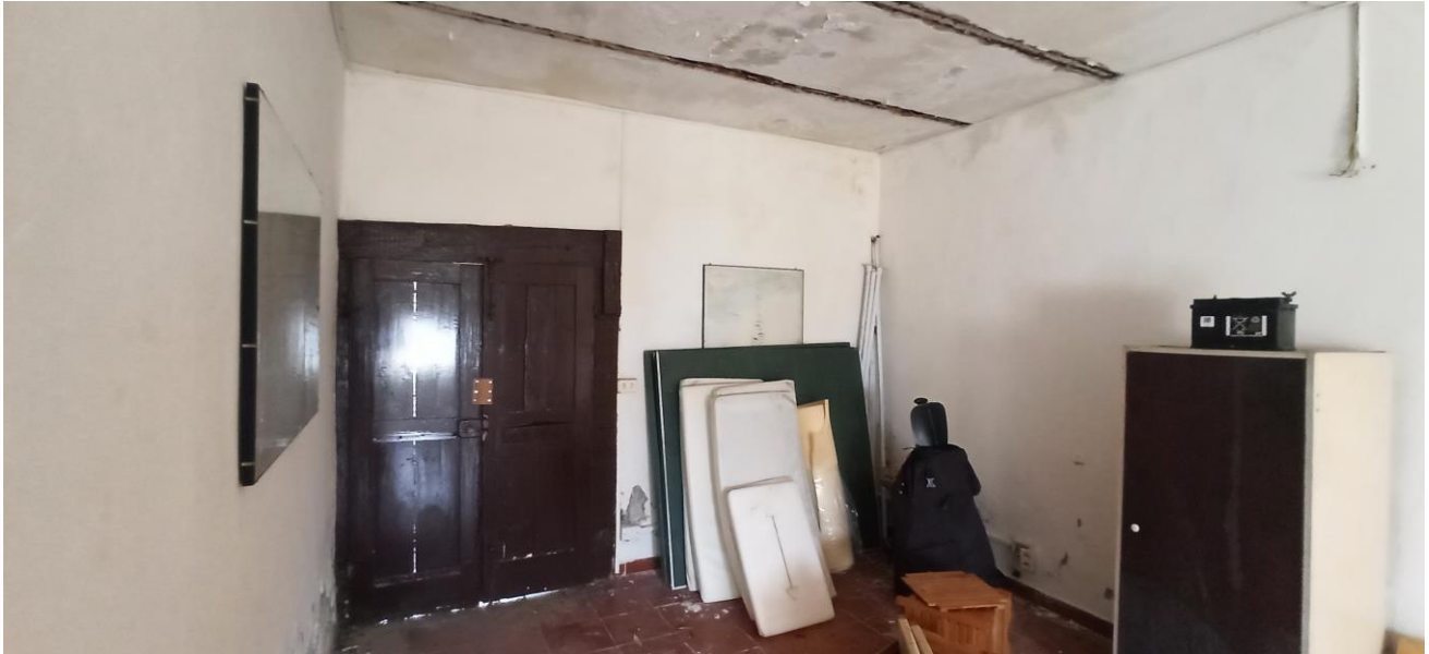
Fabbricato adiacente: locali al piano primo
