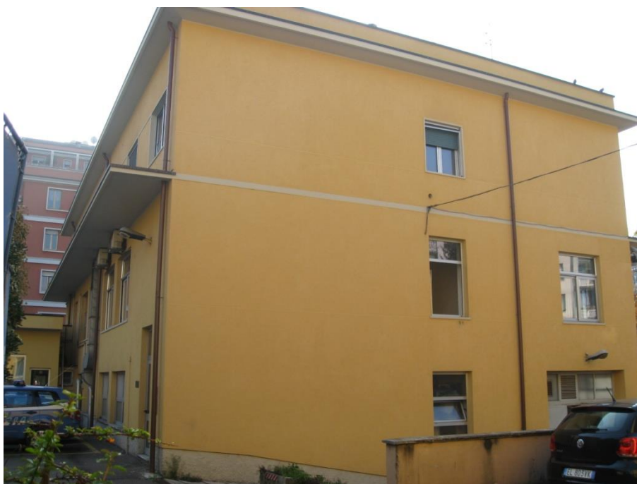
FOTO N° 7 – nuova palazzina – uffici – autorimessa (4)
