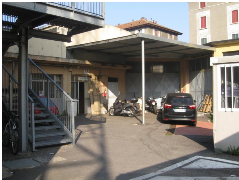
FOTO N° 11 – magazzini – spogliatoio personale (7 - 8)
