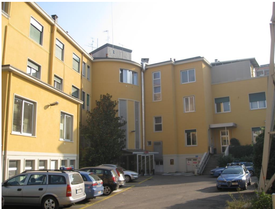
FOTO N° 9 – corpo principale – uffici – mensa – archivio (1)
