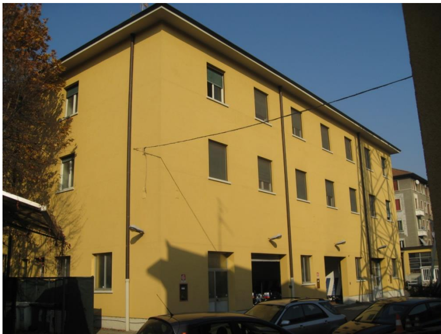
FOTO N° 5 – palazzina alloggi e officina piano terra (7)
