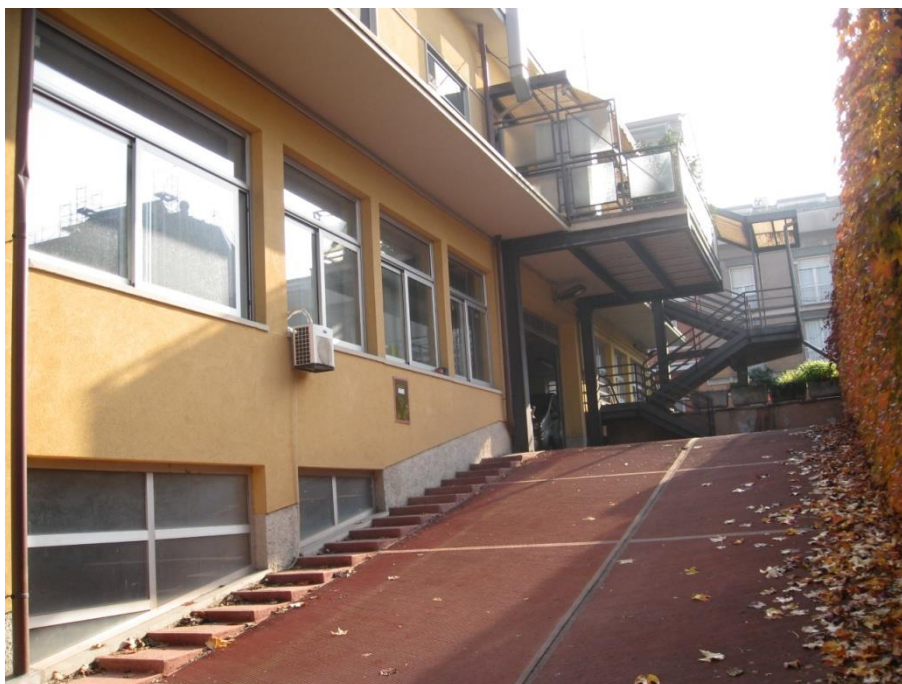
FOTO N° 17 – nuova palazzina – autorimessa (4)
