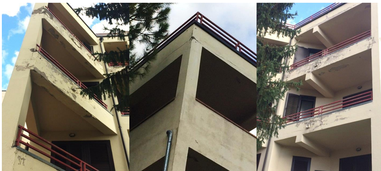
Particolari delle facciate
