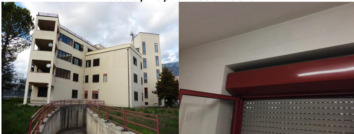
Facciata retrostante – vista interna
