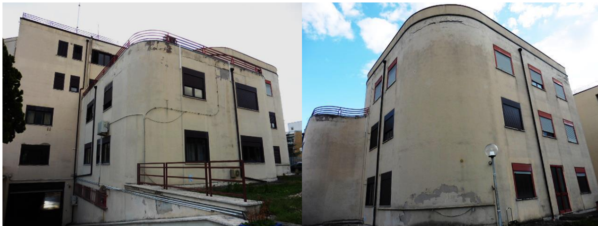
Facciata principale – vista di insieme
