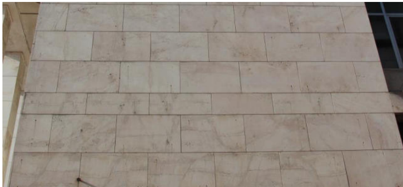
Fig. 12. Dettaglio delle lastre sul fronte nord-est
