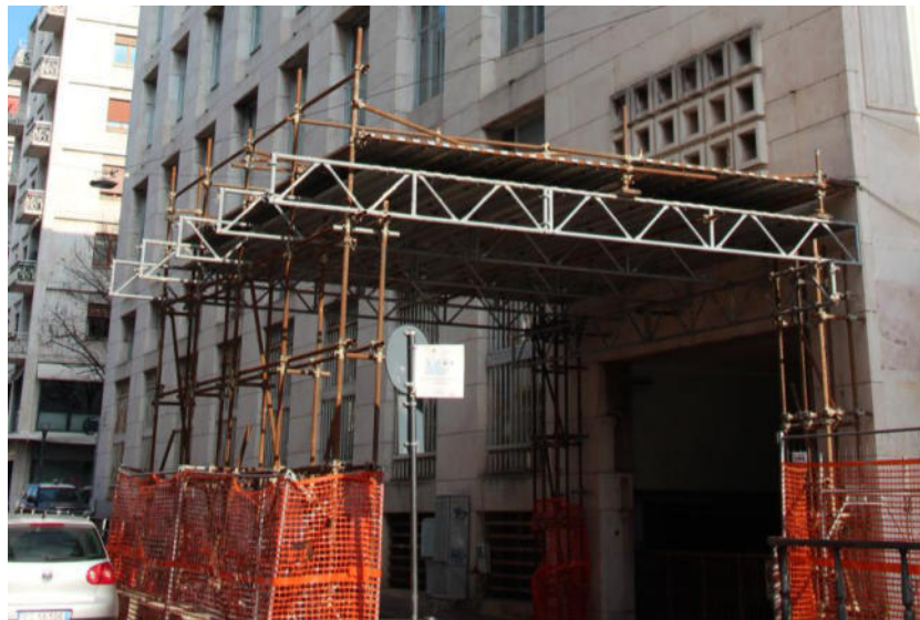
Fig. 7. Protezione dell'accesso al piano interrato sul fronte sud-ovest (2022)
