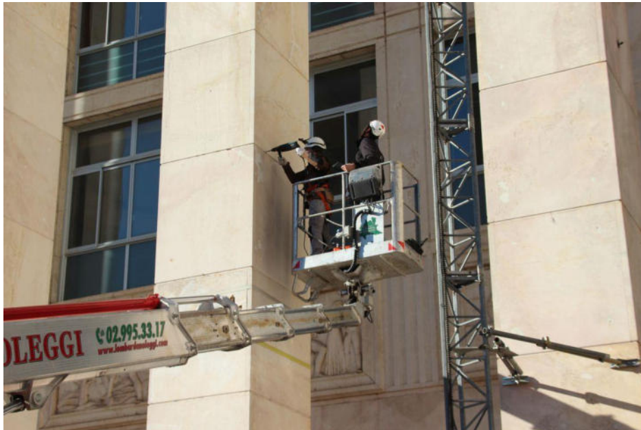
Fig. 19. Effettuazione della campagna diagnostica con l'ausilio della piattaforma aerea
