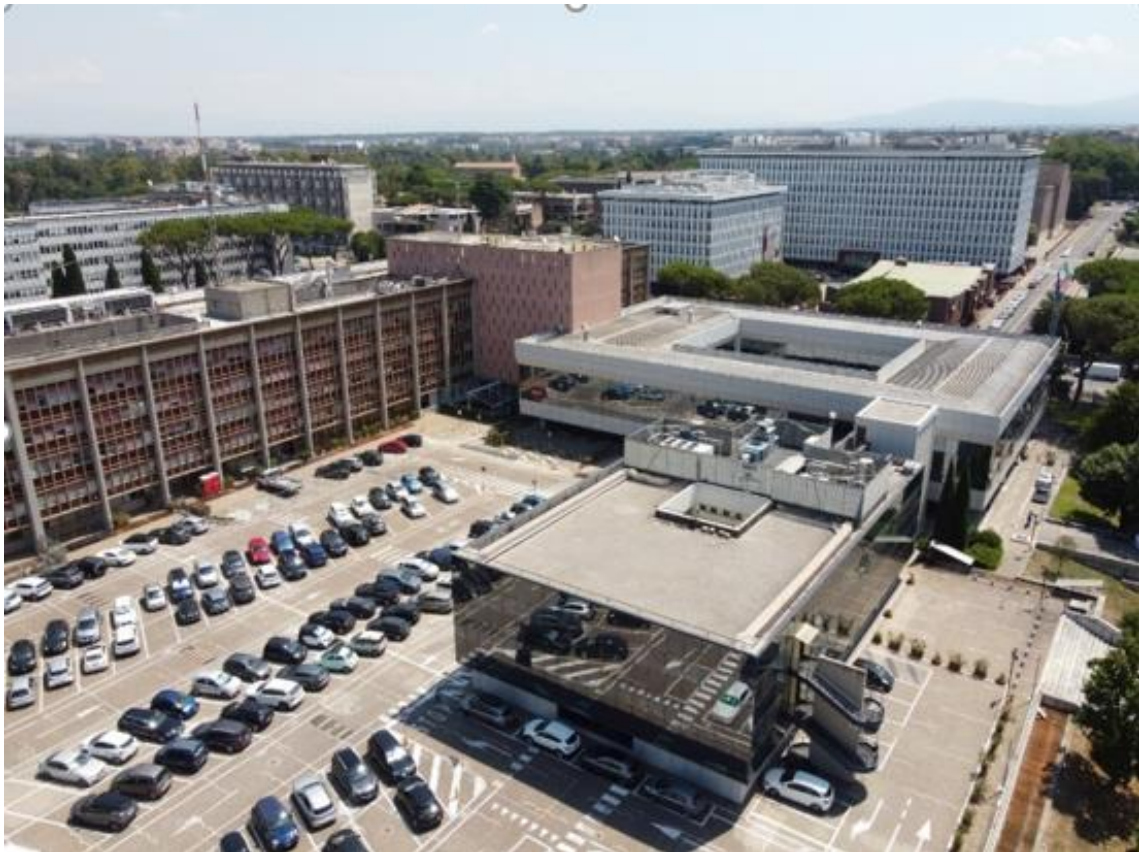
Vista del complesso con il corpo D in primo piano
