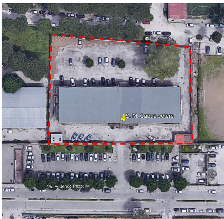
Figura 1 – Inquadramento edificio in oggetto
