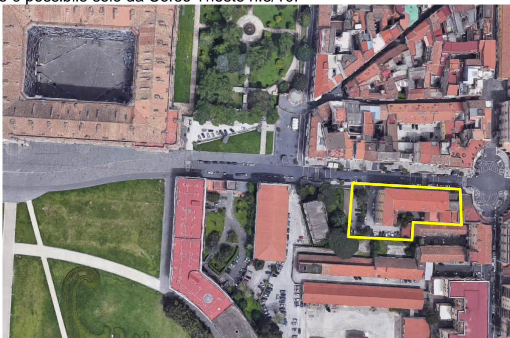
Vista aerea dell'edificio ed inserimento nel contesto urbano
