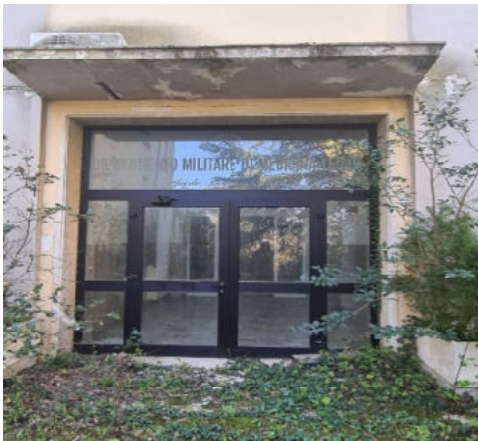
Foto 1 – ingresso piano terra
