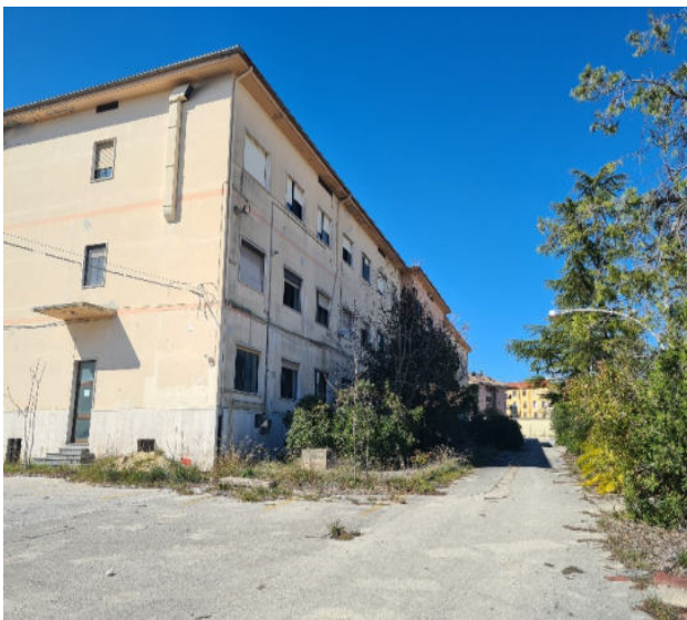
Foto 3 – vista esterna complesso
