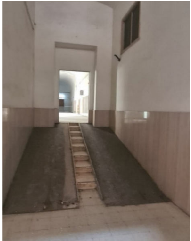
Foto 6 – vista interna piano terra
