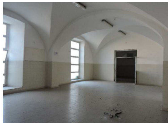
Foto 12 – sistema di archi e volte
