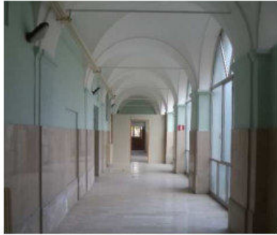
Foto 15 – presenza di volta a crociera e archi corte interna
