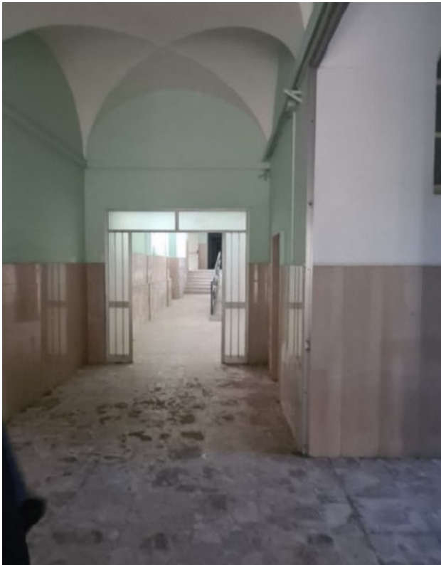
Foto 5 – vista interna piano terra
