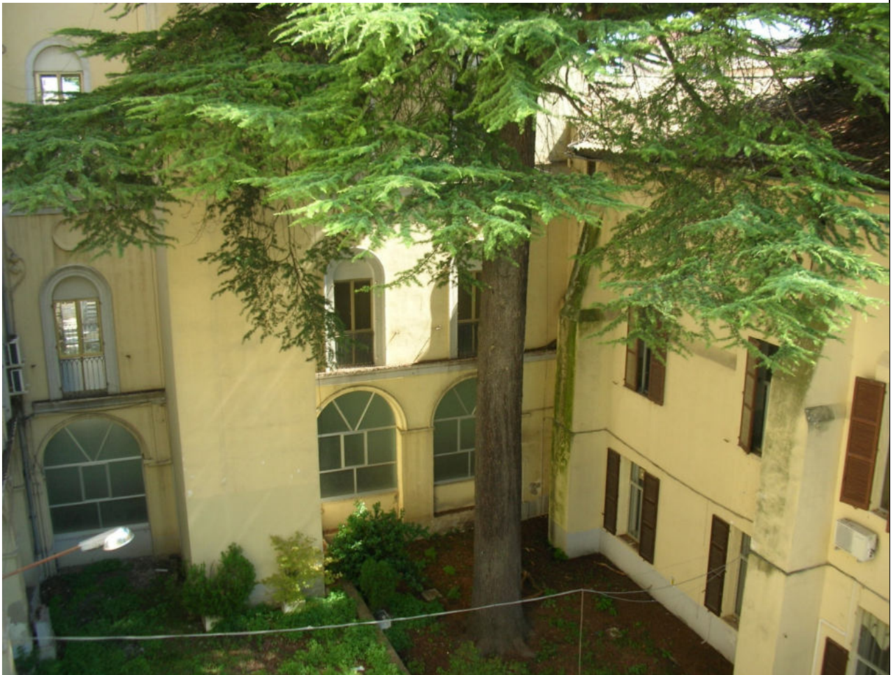
Foto 16 – vista interna chiosstro
