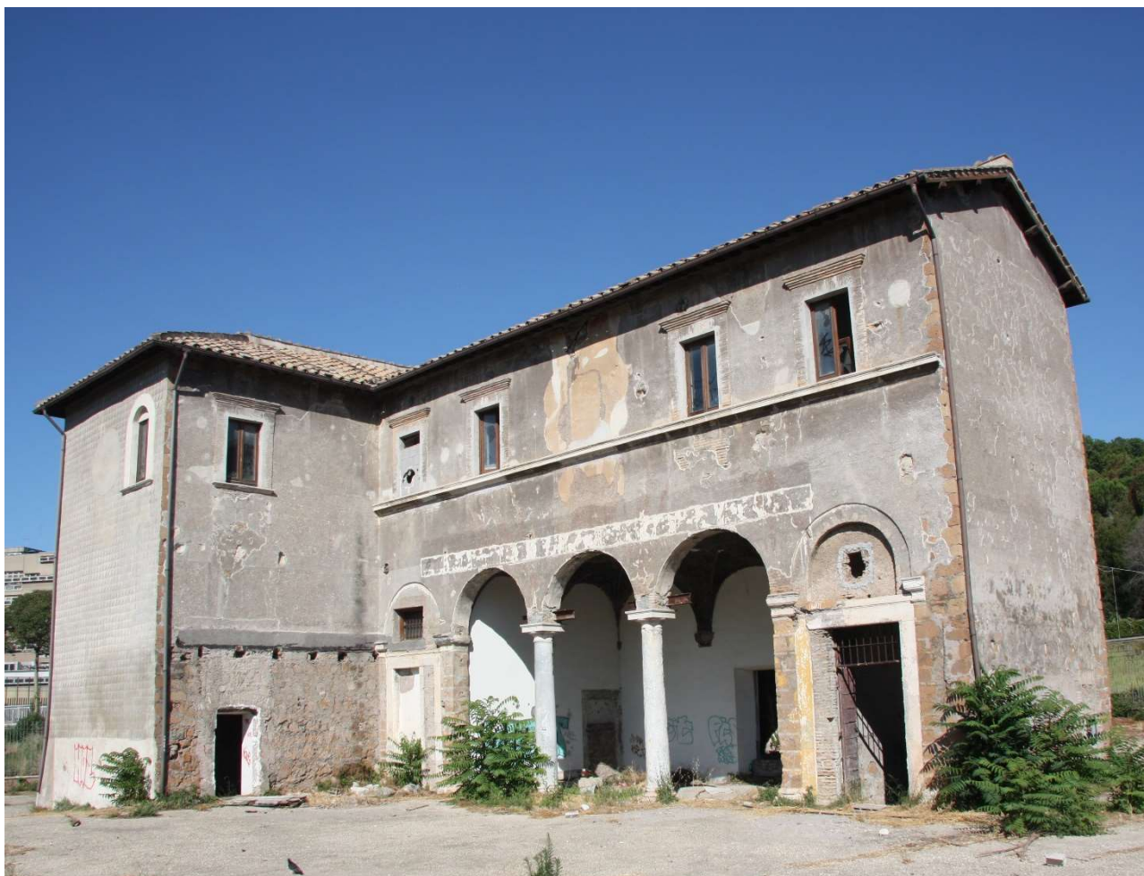
Casale Strozzi Inferiore - Veduta del fronte principale - Sud
