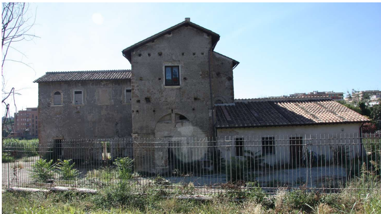
Casale Strozzi Inferiore - Veduta del fronte posteriore – Nord
