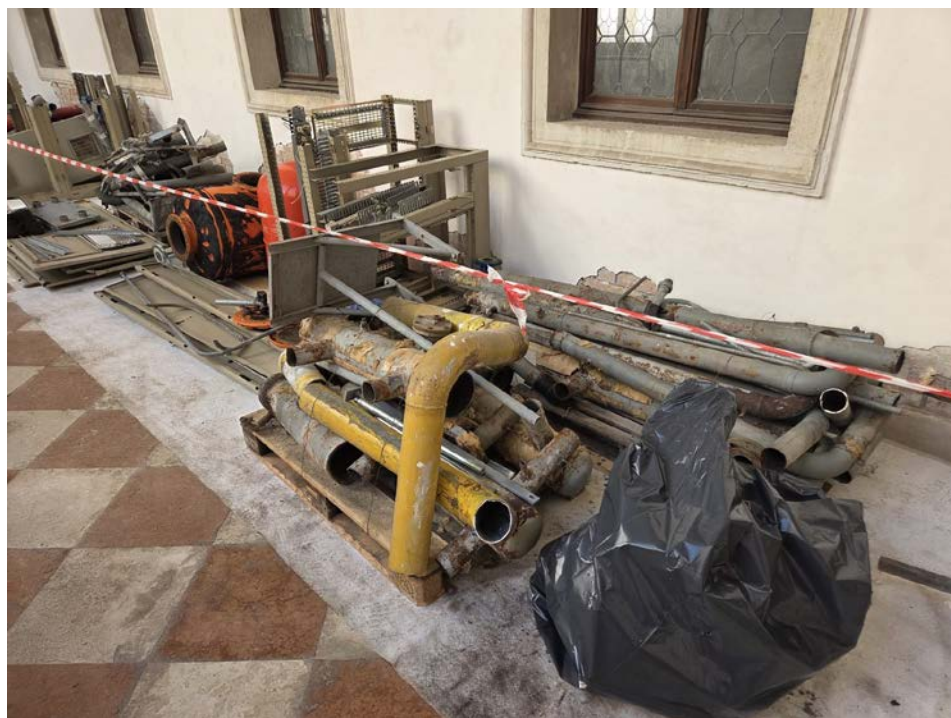
Foto C.3 – Portico del chiostro: tubazioni in acciaio con residui di coibentazione e carpenterie dei quadri smontati.
