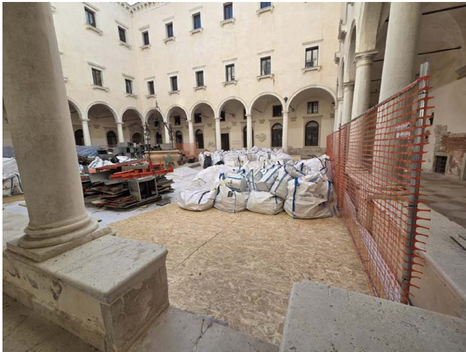
Foto G.1 – Chiostro: area di stoccaggio su pannelli OSB, delimitata da recinzione; in primo piano i sacconi dei cavi, a sinistra carpenterie dei quadri e canali.
