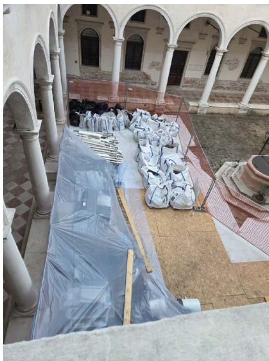
Foto G.2 – Chiostro, vista dall'alto: sacconi su bancali, materiale sotto telo in nylon e recinzione dell'area.
