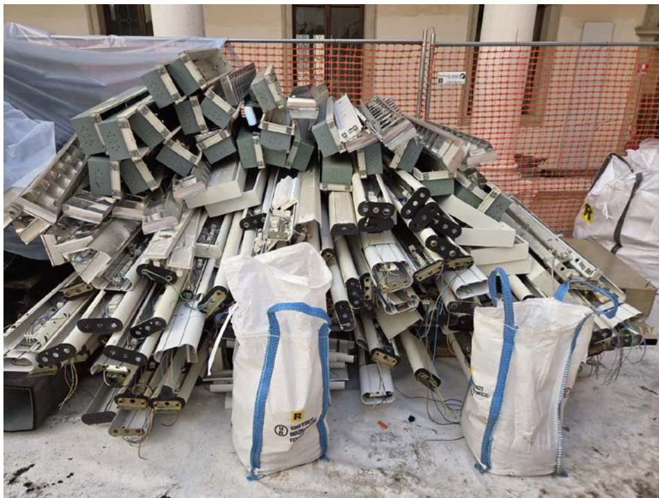
Foto E.1 – Chiostro: corpi lampada dismessi (plafoniere per tubi fluorescenti e apparecchi a riflettore), privi di sorgenti luminose.
