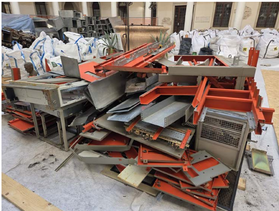
Foto C.1 – Chiostro: carpenterie metalliche dei quadri smontati e passerelle portacavi in lamiera zincata; sullo sfondo, canali dell'aria e tubazioni.
