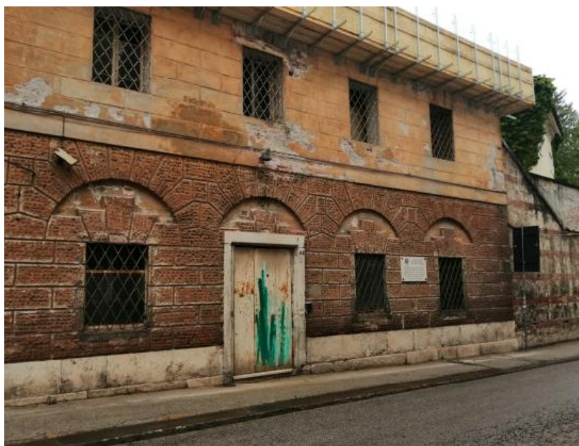
Veduta esterna porzione ex Carcere Giudiziario
