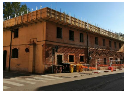
FOTO 5 Facciata lato Sud
