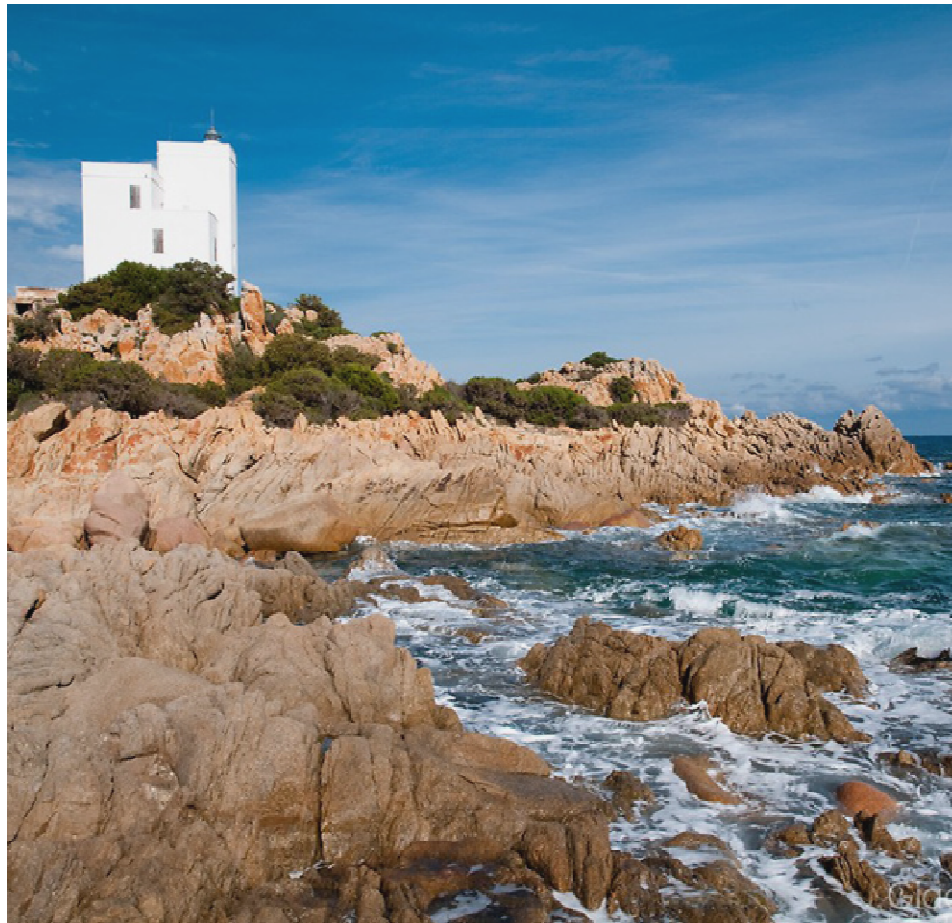
Strada Statale 125, località Capo Comino – 08020 Siniscola (NU)
