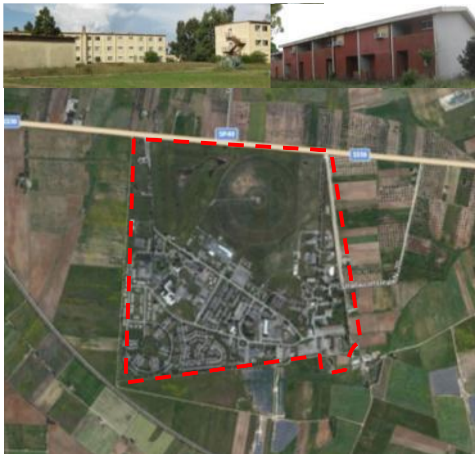
SS16 - San Vito dei Normanni -Brindisi
