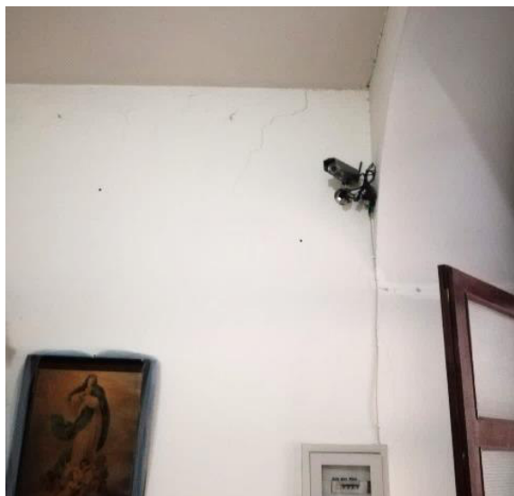
Figura 28 – vista interna piano primo
