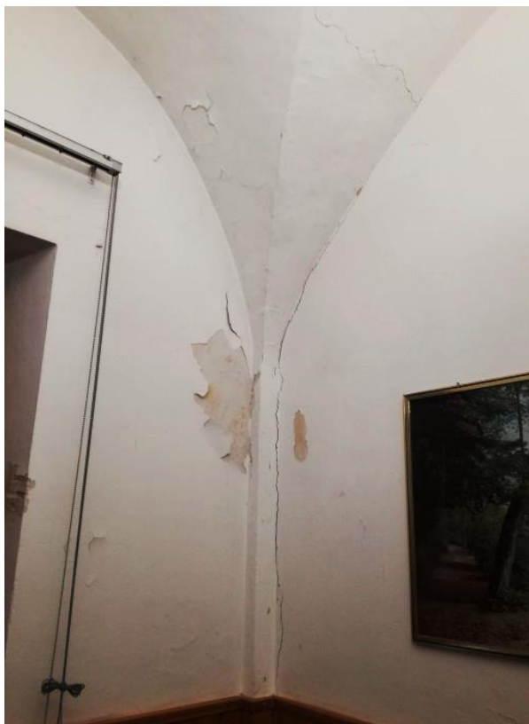
Figura 17 – vista interna piano primo
