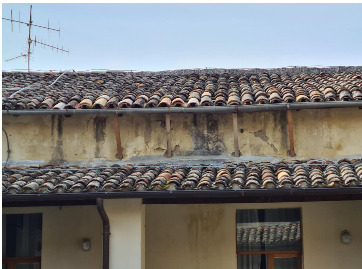
Figura 35 – copertura lato chiostro interno
