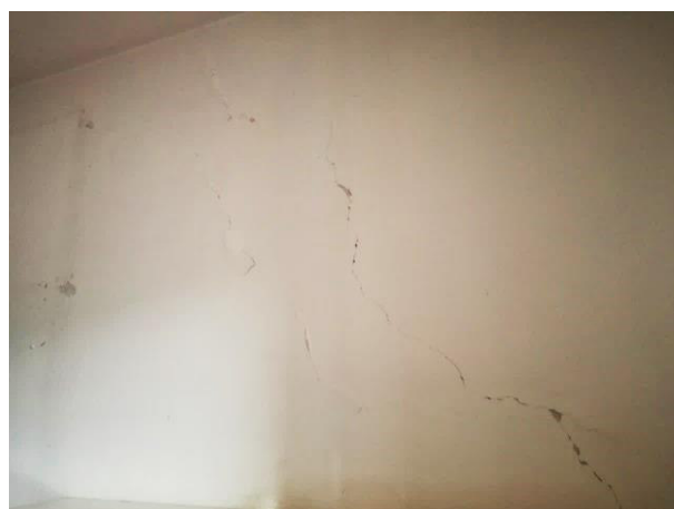
Figura 31 – vista interna piano primo
