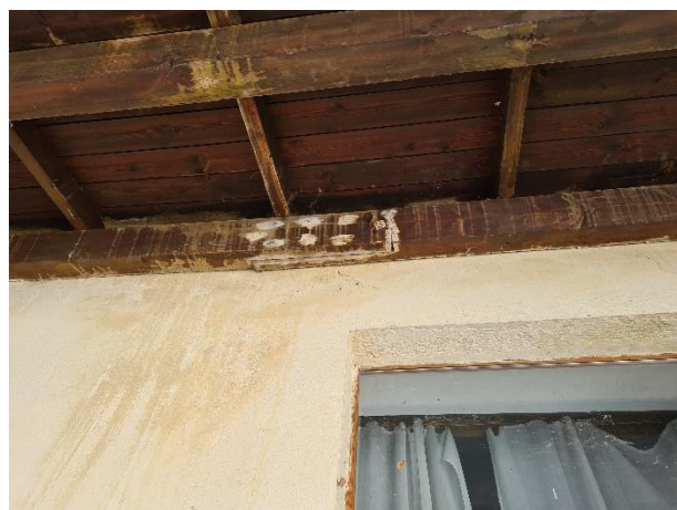
Figura 24 – vista copertura dal chiostro piano primo
