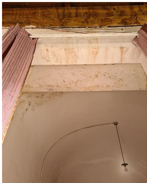
Figura 34 – vista interna piano primo
