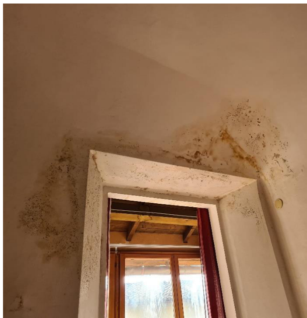
Figura 33 – vista interna piano primo
