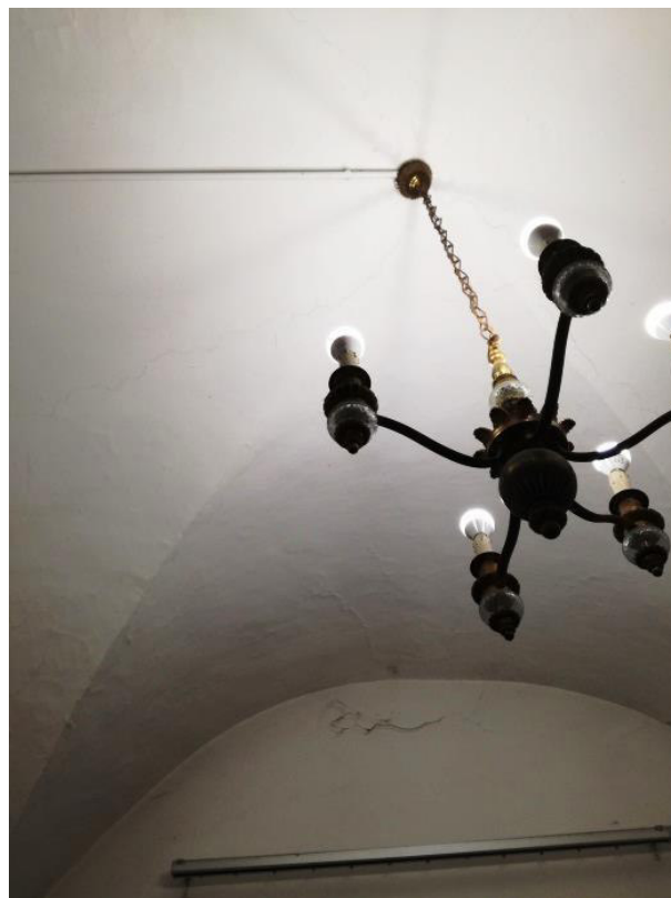
Figura 18 – vista interna piano primo
