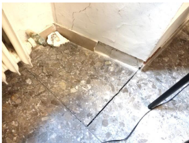
Figura 20 – vista interna piano primo
