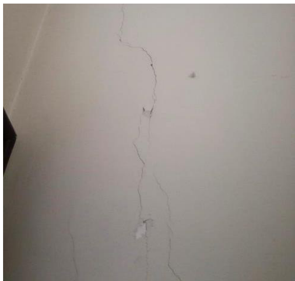
Figura 27 – vista interna piano primo
