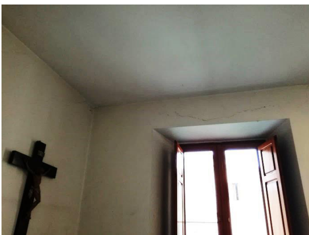
Figura 15 – vista interna piano primo
