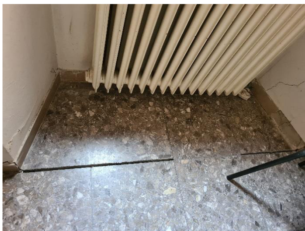
Figura 19 – vista interna piano primo
