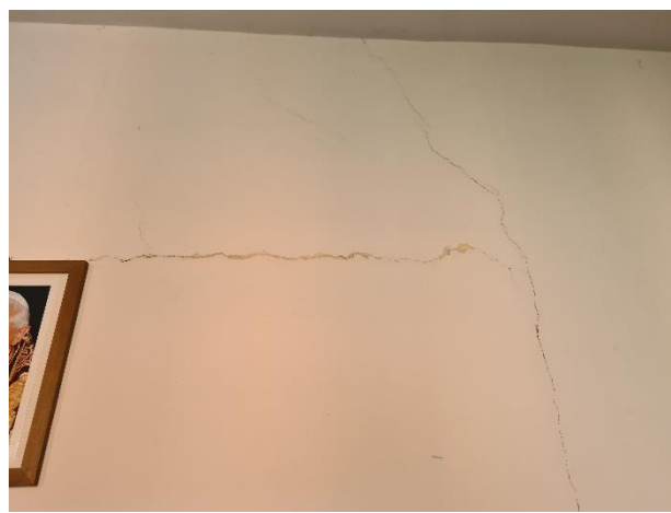
Figura 16 – vista interna piano primo
