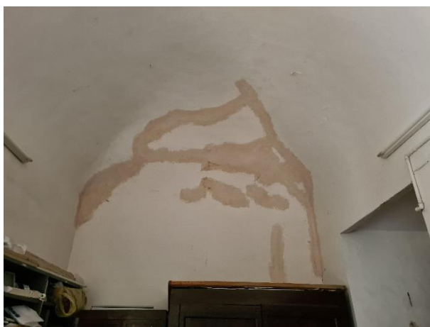
Figura 23 – vista interna piano primo
