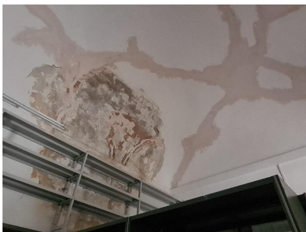
Figura 21 – vista interna piano primo
