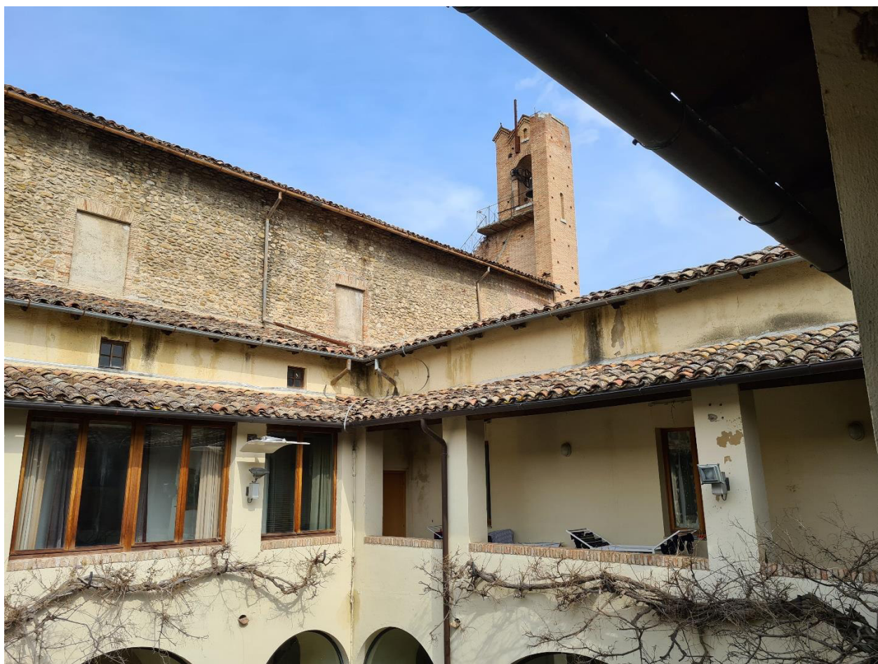
Figura 36 – vista chiostro interno piano primo
