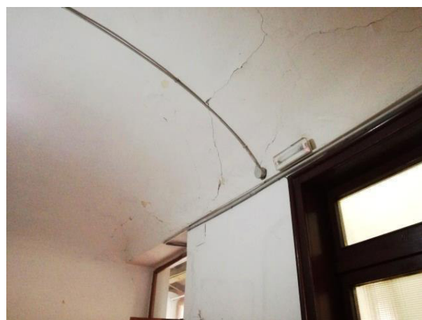
Figura 32 – vista interna piano primo
