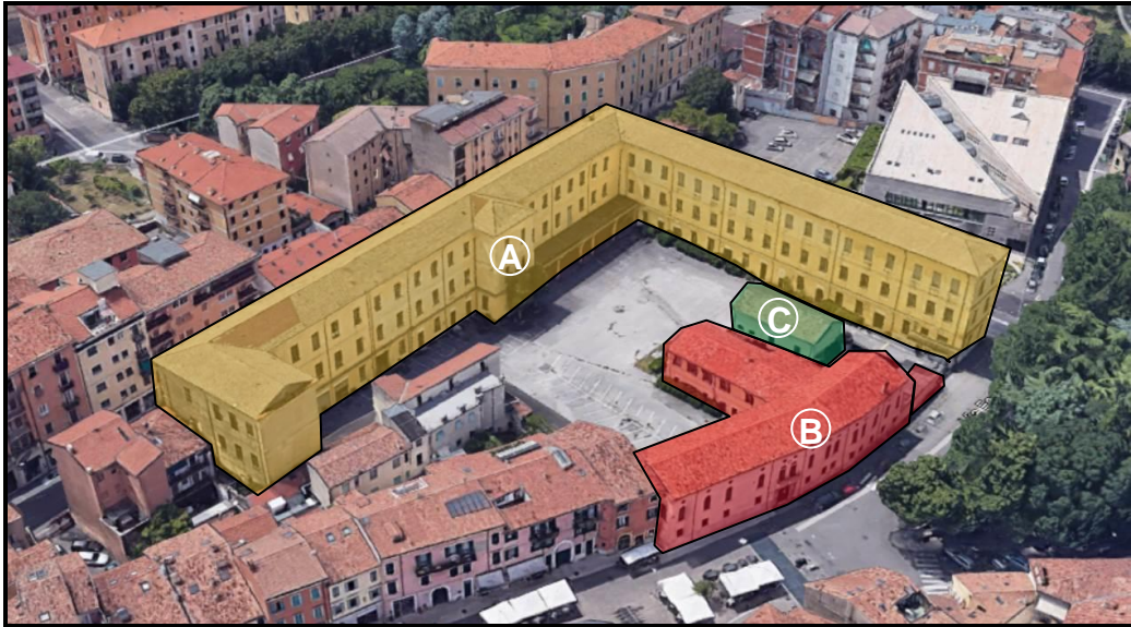
Foto aerea con indicazione degli immobili oggetto di intervento
