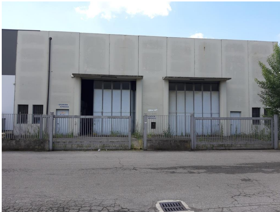
Figura 9 – Facciata capannone identificato al foglio 4, particella 239, sub. 1
