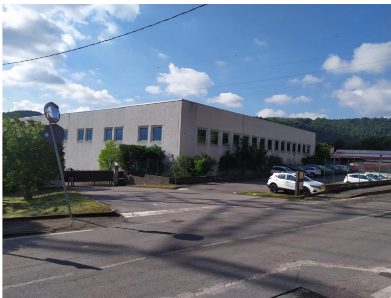
Figura 21 – Facciata del capannone dall'ingresso di via Rizzardi
