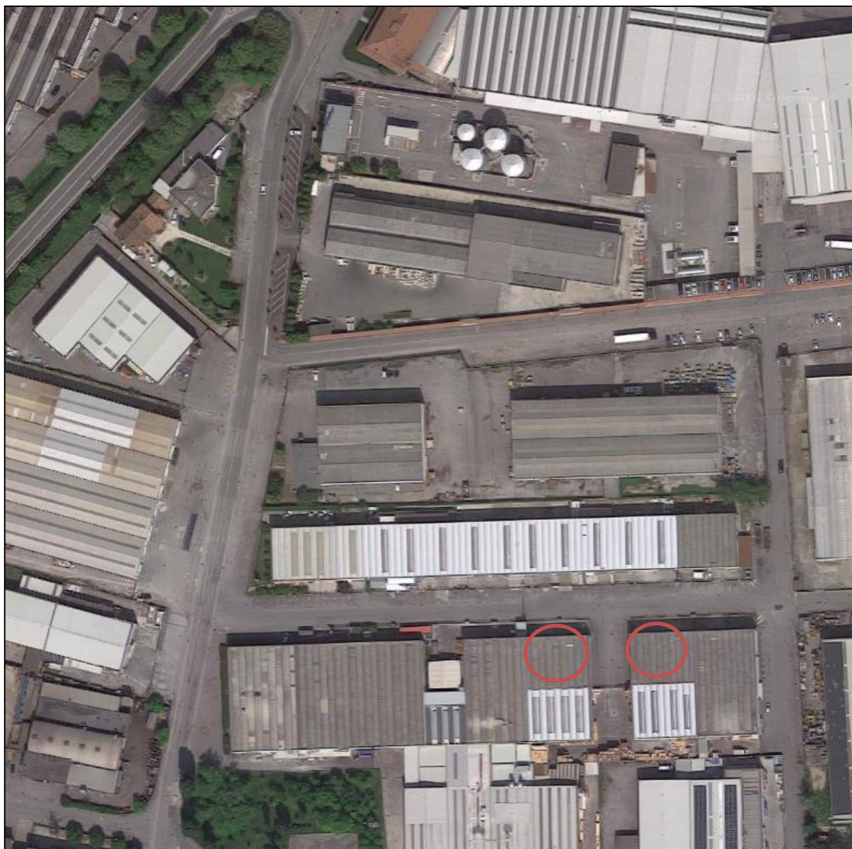
Figura 5 – Flero, vista aerea dei capannoni destinati alla Prefettura di Brescia
