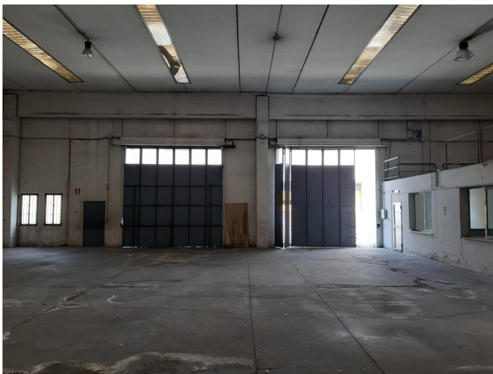
Figura 10 – Interno del capannone identificato al foglio 4, particella 239, sub. 1
