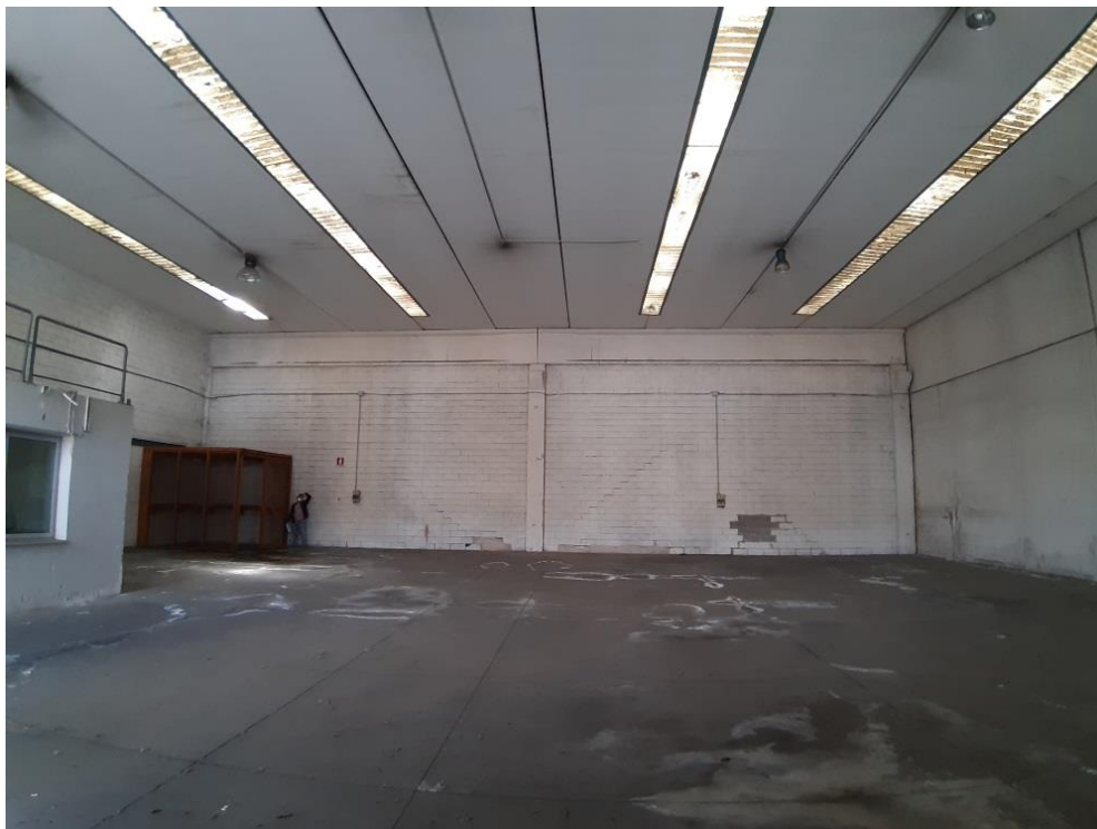
Figura 11 – Interno del capannone identificato al foglio 4, particella 239, sub. 1
