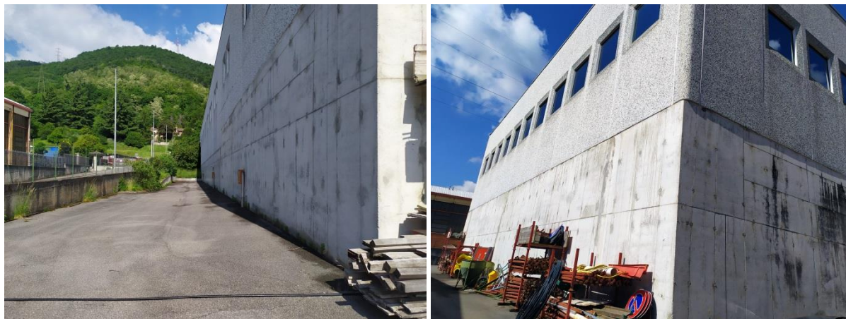
Figura 22 – Vista del prospetto posteriore del capannone
