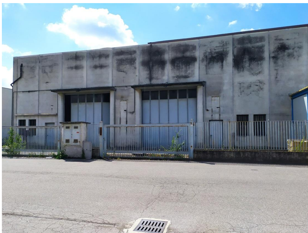
Figura 12 – Facciata capannone identificato al foglio 4, particella 432, sub. 3
