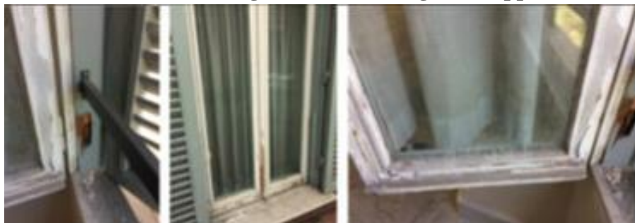
Infisso porta/finestra con telaio in legno, con vetro singolo e doppio:
