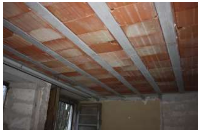
Porzioni di solaio ricostruite
