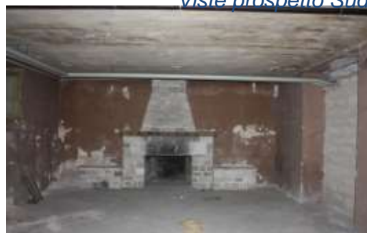
Ambiente piano seminterrato
