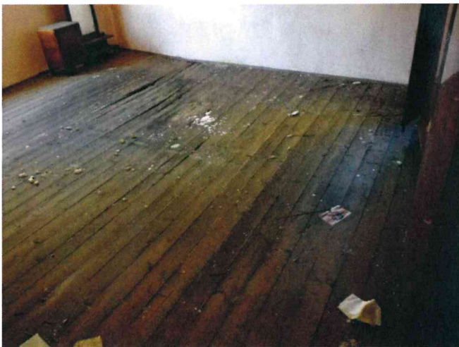
Fig. 6 Solaio in legno di interpiano in corrispondenza del sottoportico
