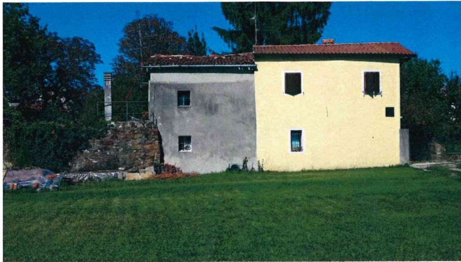
Fig. 3 Contiguità del fabbricato demaniale (grigio) con la proprietà di terzi.
