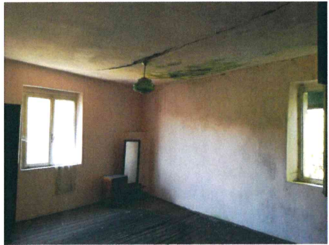
Fig. 7 Controsoffitto interno in corrispondenza del sottoportico
