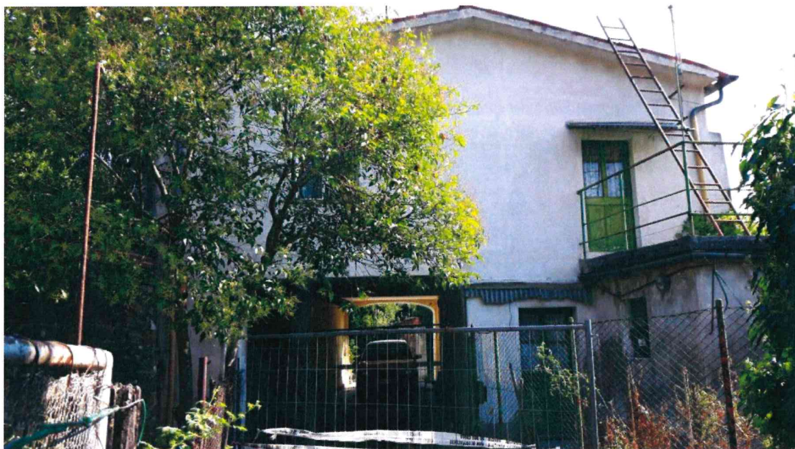
Fig. 2 Fronte del fabbricato verso l'accesso pedonale da via Udine
