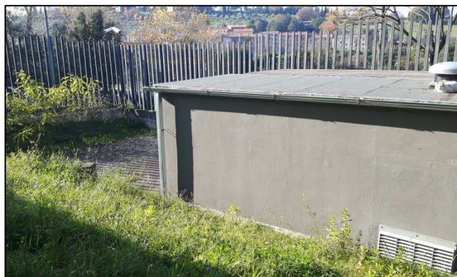
Foto 8: Cabina elettrica (su p.lla 5200)
