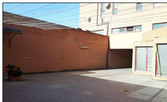
Foto 6: Cortile interno alla Caserma (piano terra)
