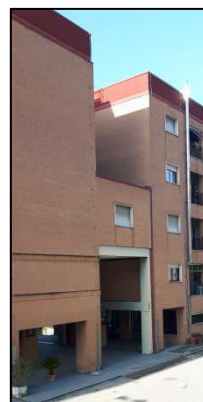
Foto 4: Androne di collegamento tra "fabbricato Caserma" ed "fabbricato alloggi"
