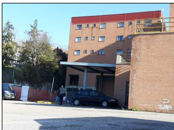
Foto 10: Corte a Nord-Ovest con impianto di distribuzione di carburante
