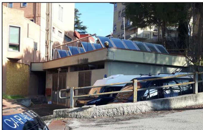
Foto 9: Fabbricato con impianti tecnologici
