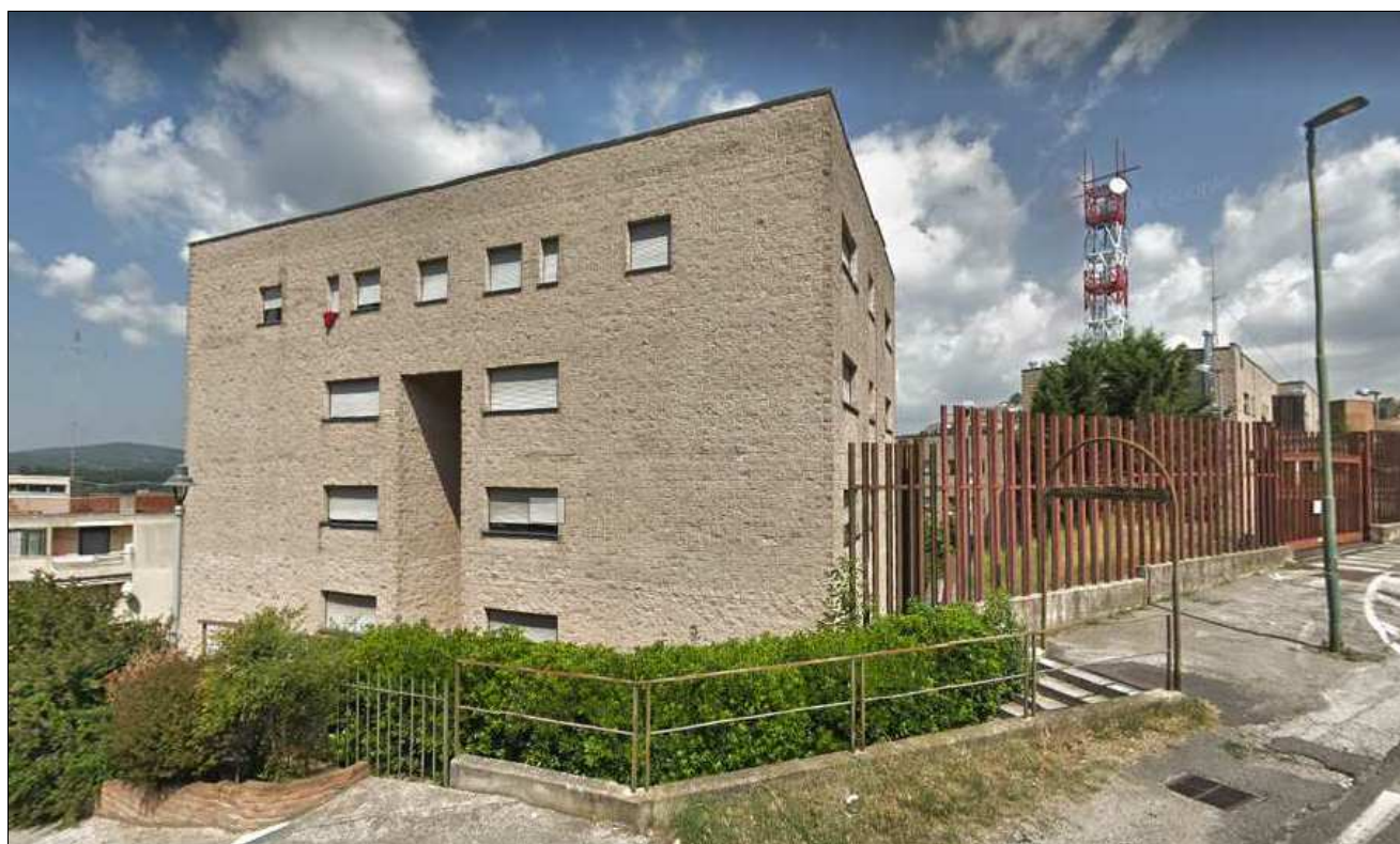
Palazzina alloggi (dalla strada)
