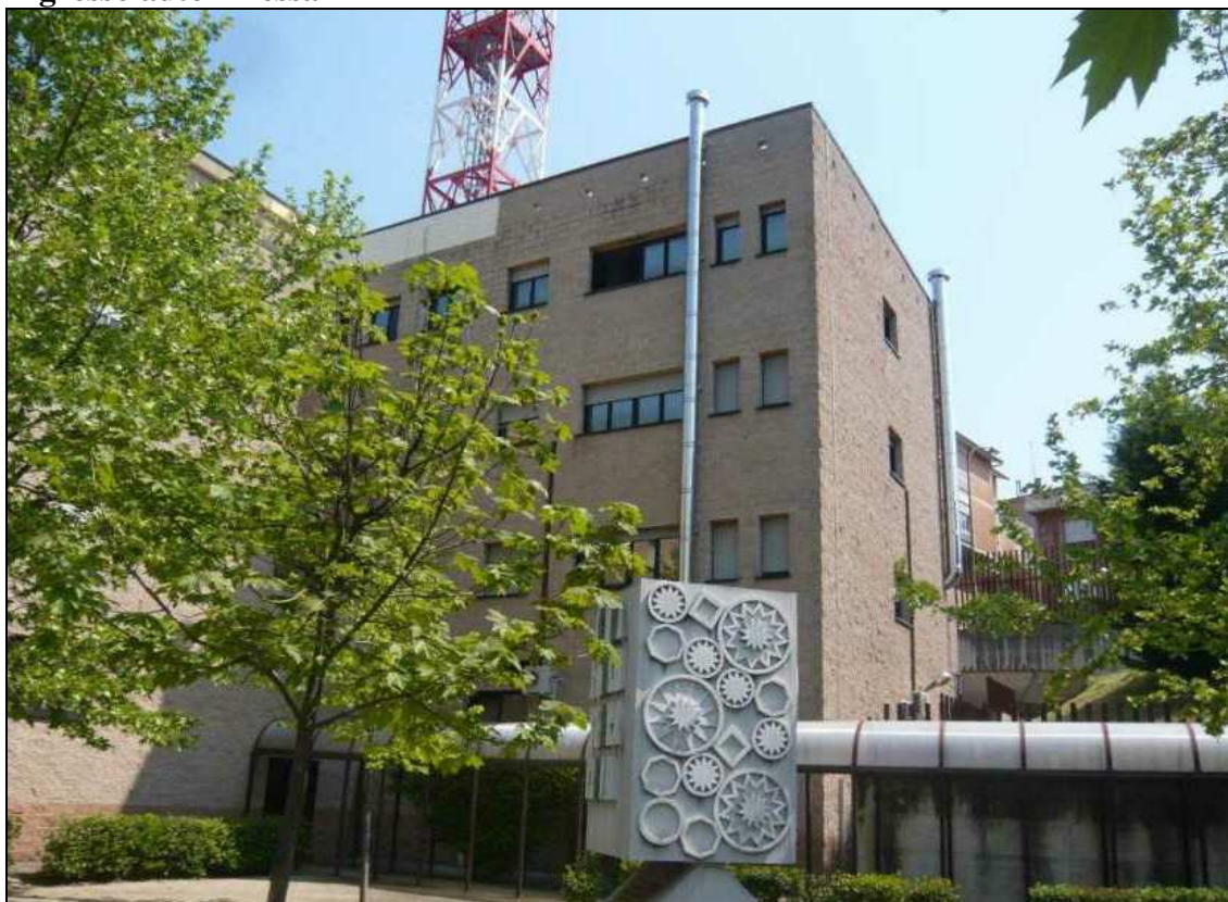
Caserma (dal cortile interno)
