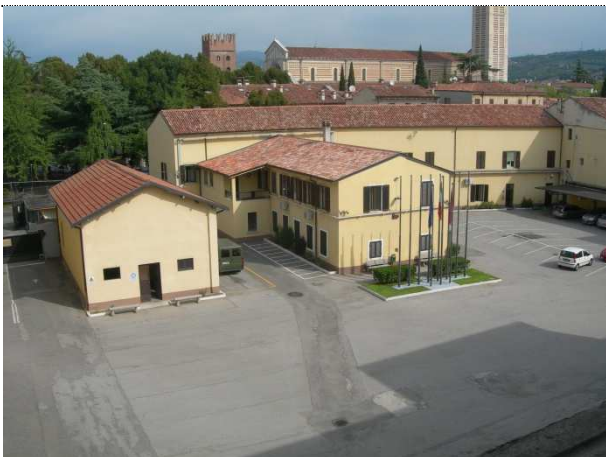
Figura 5: Vista dall'interno del piazzale degli edifici B e C
