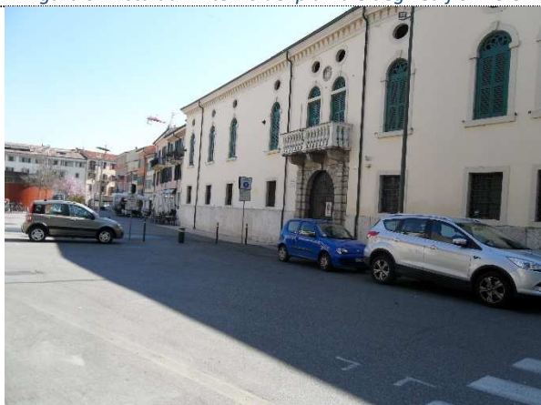
Figura 7: Vista esterna edificio vincolato B
