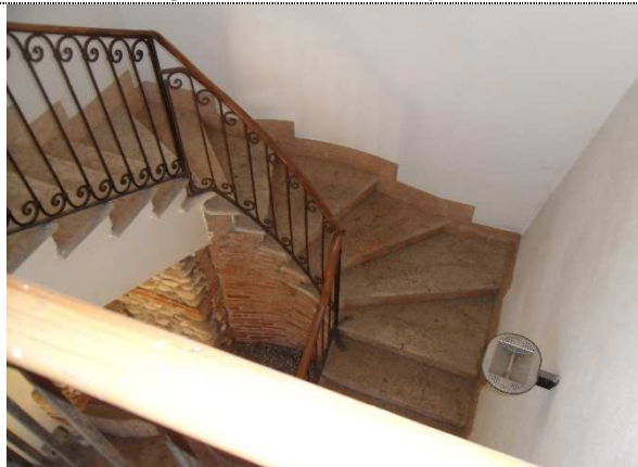
Figura 15: Vista scala esistente interna al corpo B
