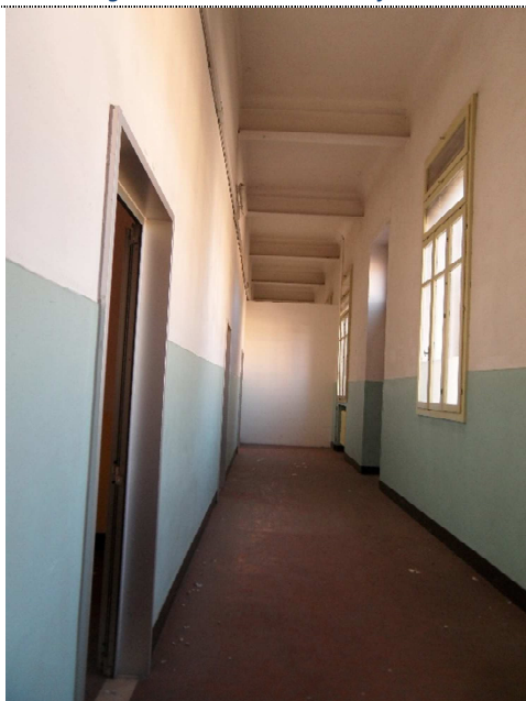
Figura 13: Vista interna edificio A
