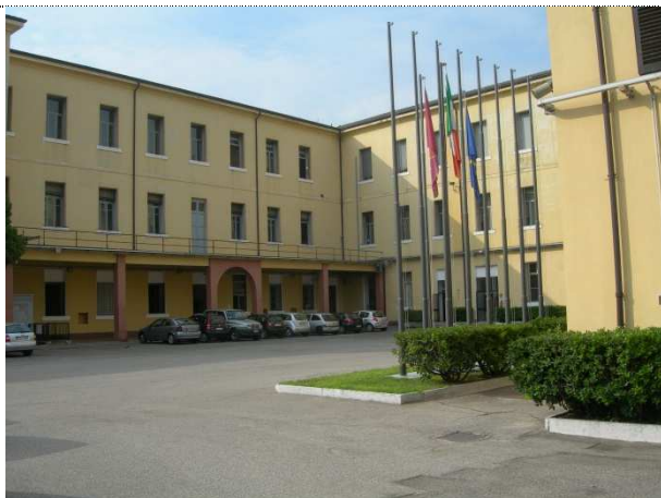
Figura 6: Vista all'interno del piazzale dell'edificio A
