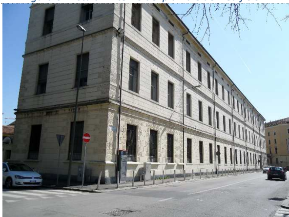
Figura 8: Vista esterna edificio A
