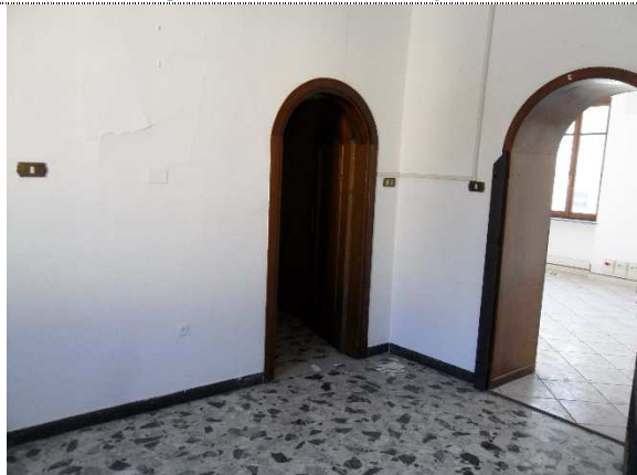
Figura 16: Vista interna edificio B
