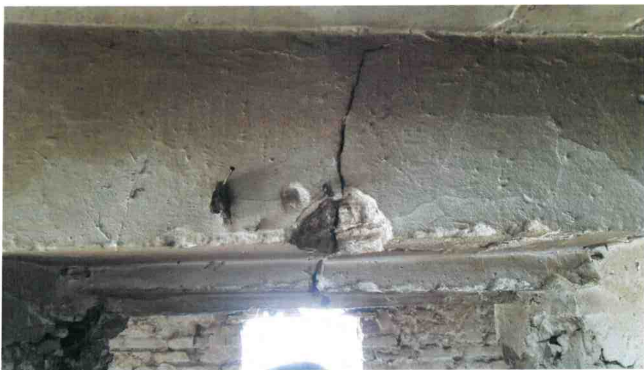
Fig. 12 – Architrave muro interno corpo di fabbrica B visto da Ovest
