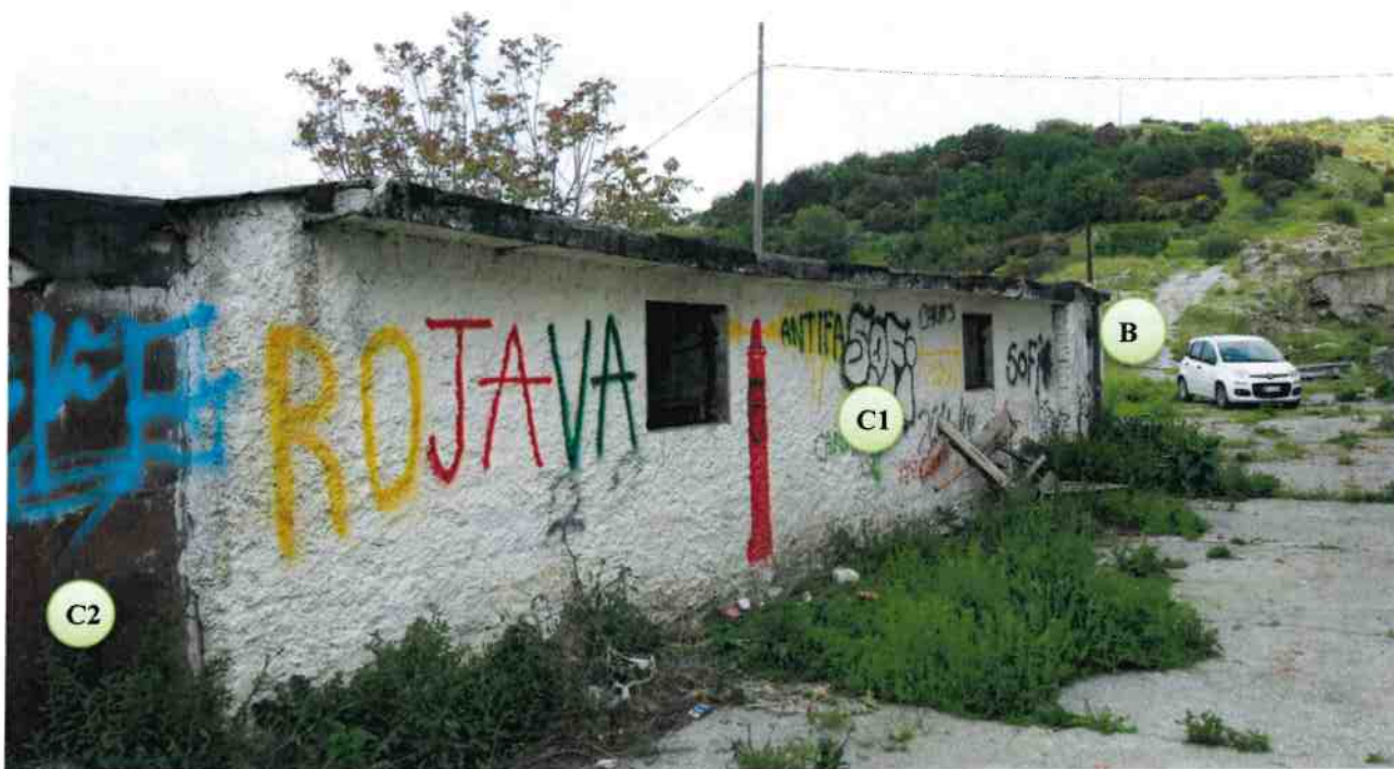
Fig. 7 – Corpi di fabbrica da demolire visti da Sud-Est
