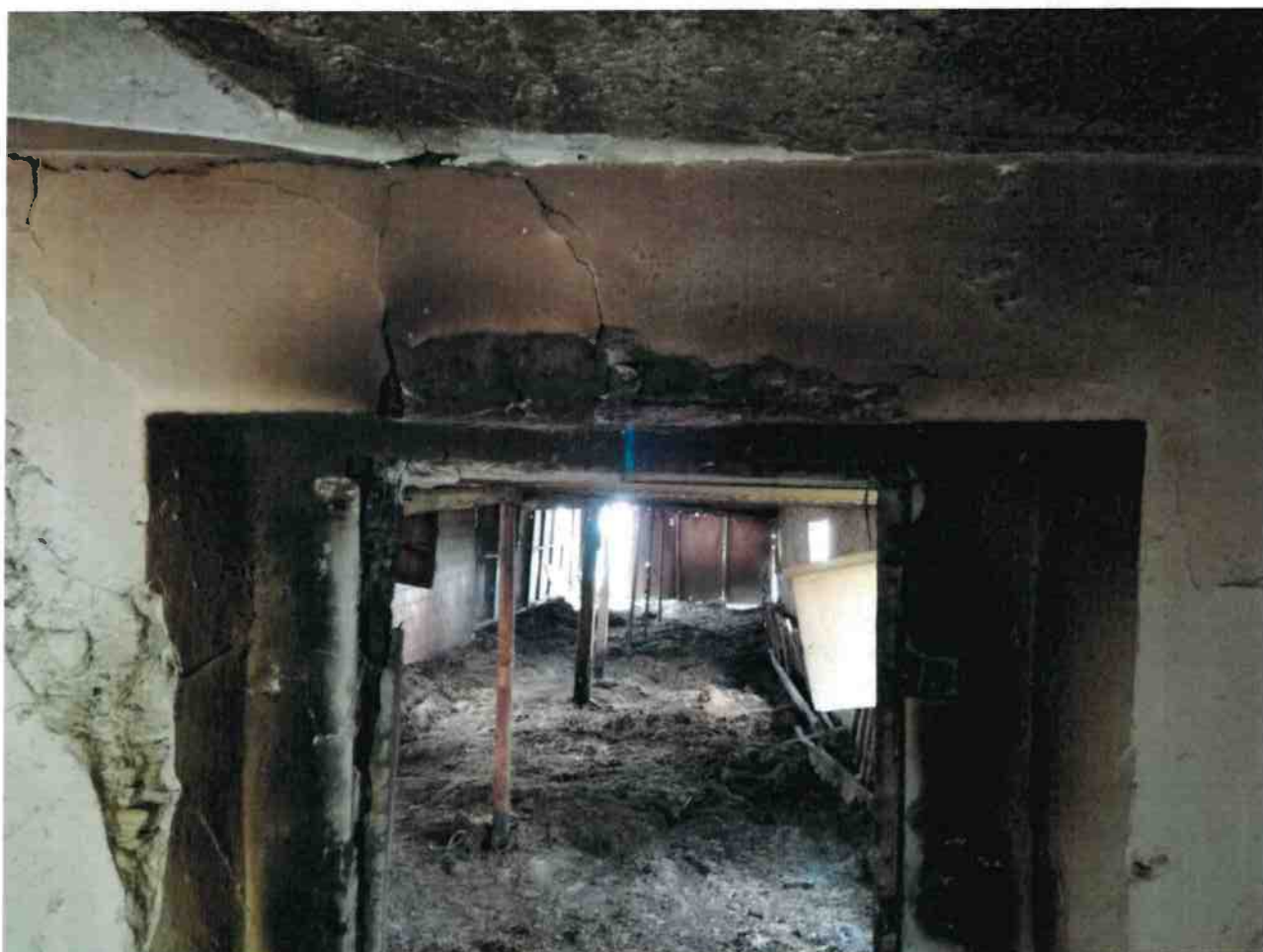
Fig. 13 – Architravi muro di separazione tra corpi di fabbrica B e C1 visto da Nord
