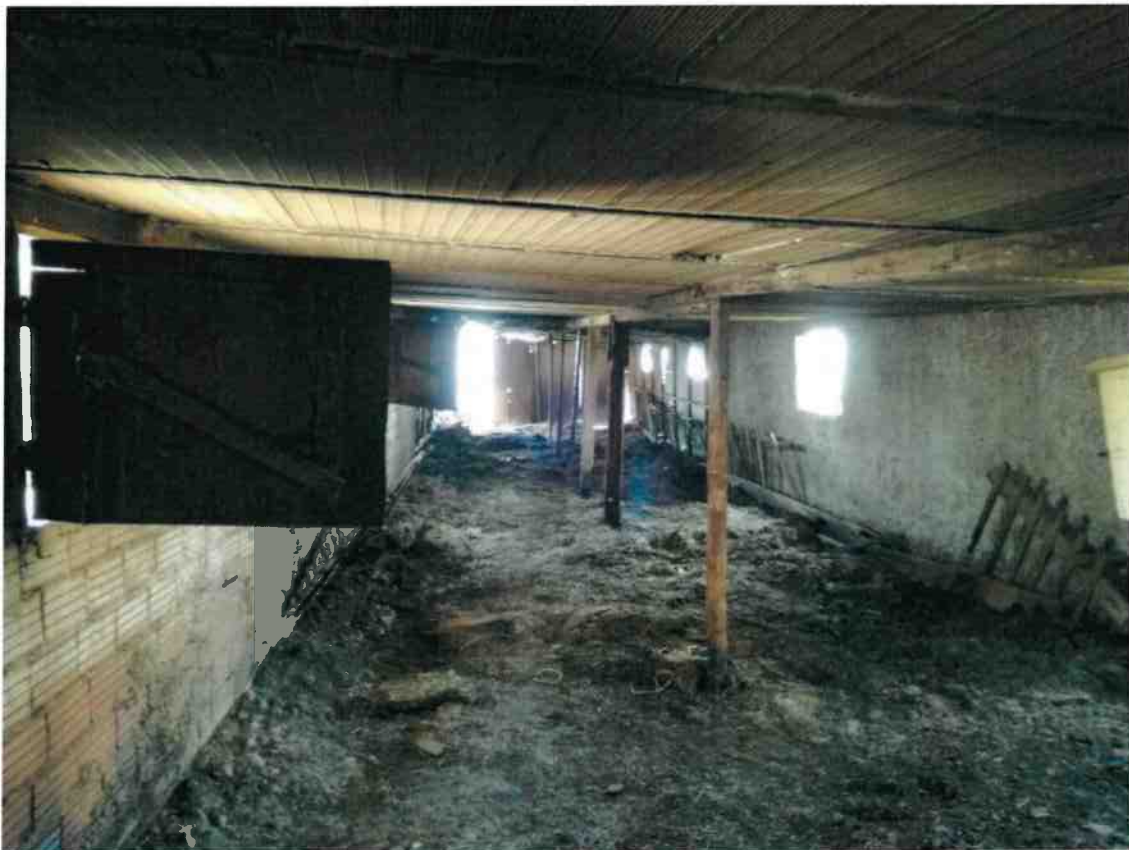
Fig. 15 – Interno corpi di fabbrica C1 visto da Nord
