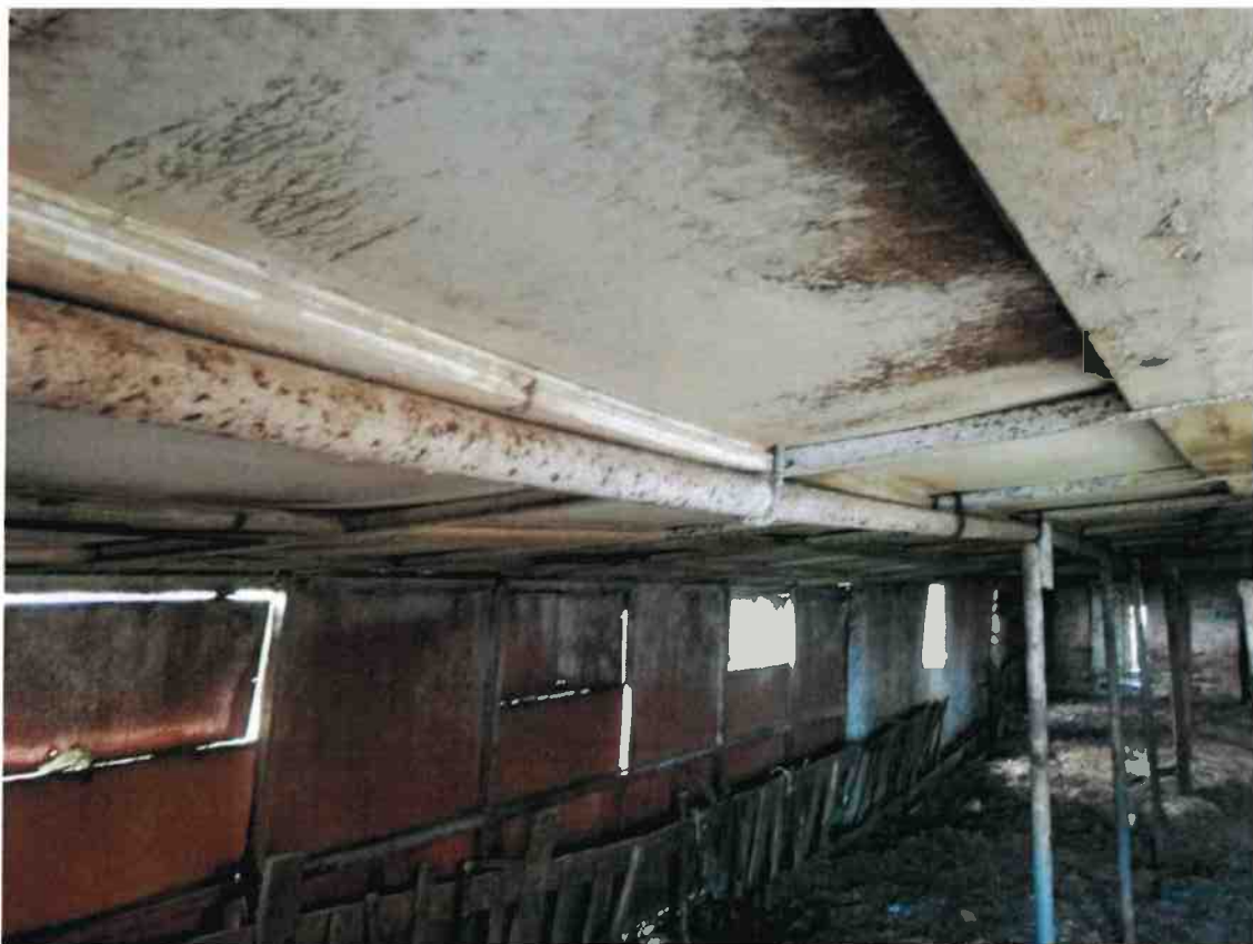
Fig. 19 – Interno corpi di fabbrica C2 visto da Sud
