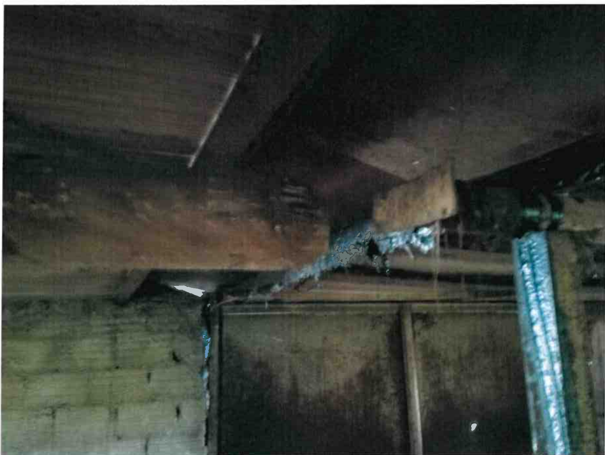
Fig. 21 – Particolare connessione tra corpi di fabbrica C1 e C2 (visto da Ovest)
