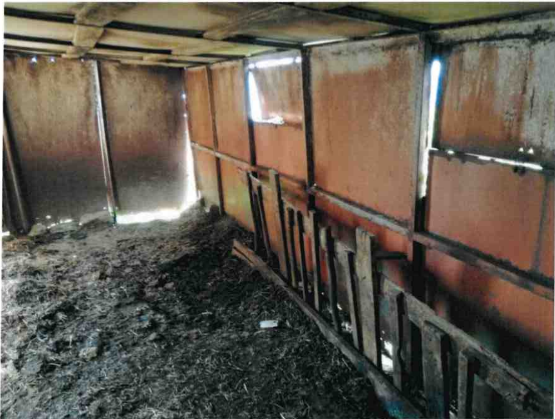
Fig. 18 – Interno corpi di fabbrica C2 visto da Nord
