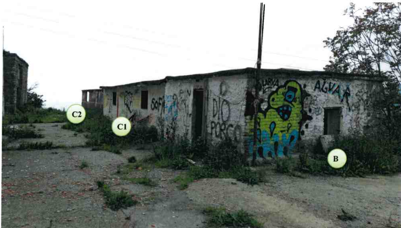
Fig. 3 – Corpi di fabbrica da demolire visti da Nord-Est
