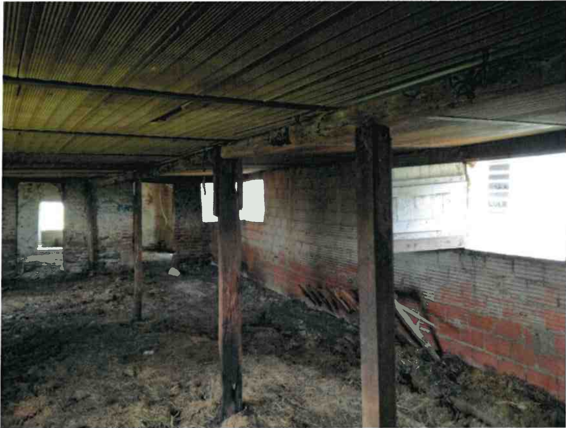
Fig. 14 – Interno corpi di fabbrica C1 visto da Sud
