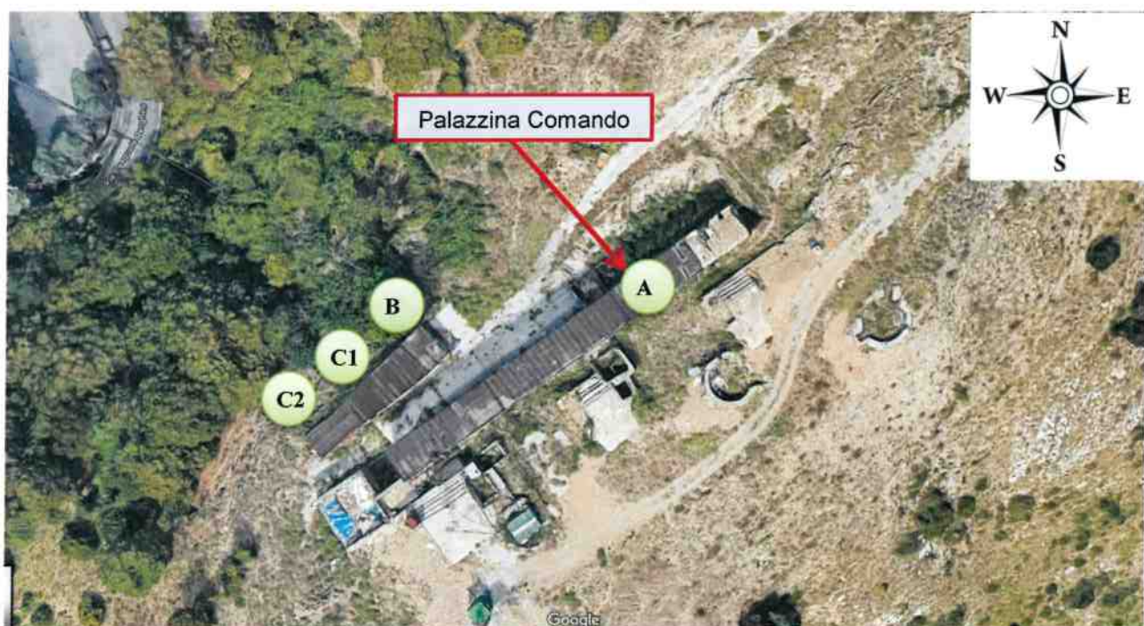
Fig. 1 – Compendio immobiliare “ex Batteria Sud Forte Richelieu” con evidenziato il corpo di fabbrica A - “Palazzina Comando” ed i manufatti B, C1 e C2 da demolire
