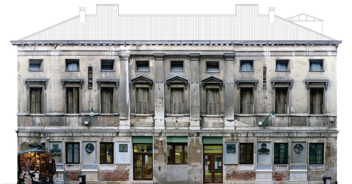
Fotoraddrizzamento facciata verso calle larga de l'Ascension
