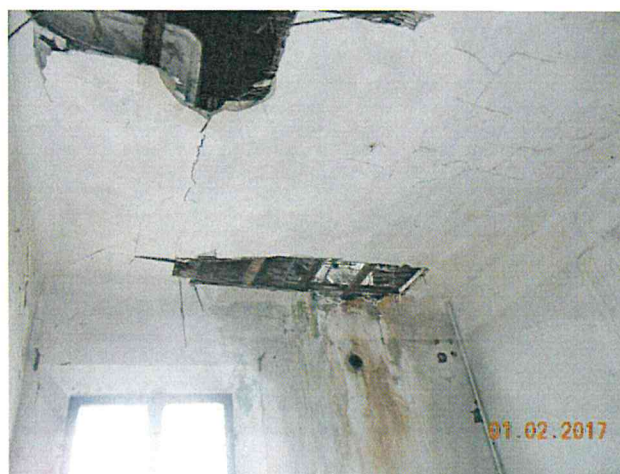
Particolare cedimento solaio sottotetto
