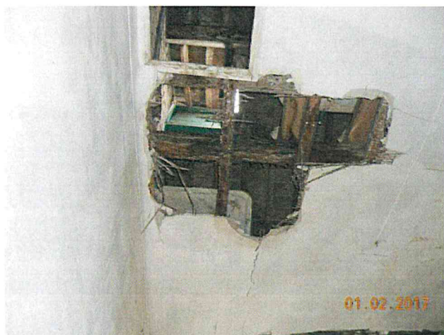
Particolare cedimento solaio sottotetto
