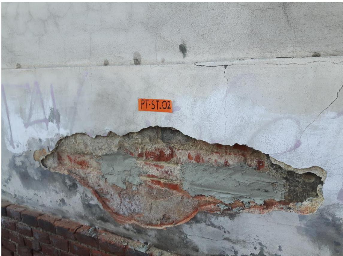
Figura 8: Ripristino della prova Shove Test
