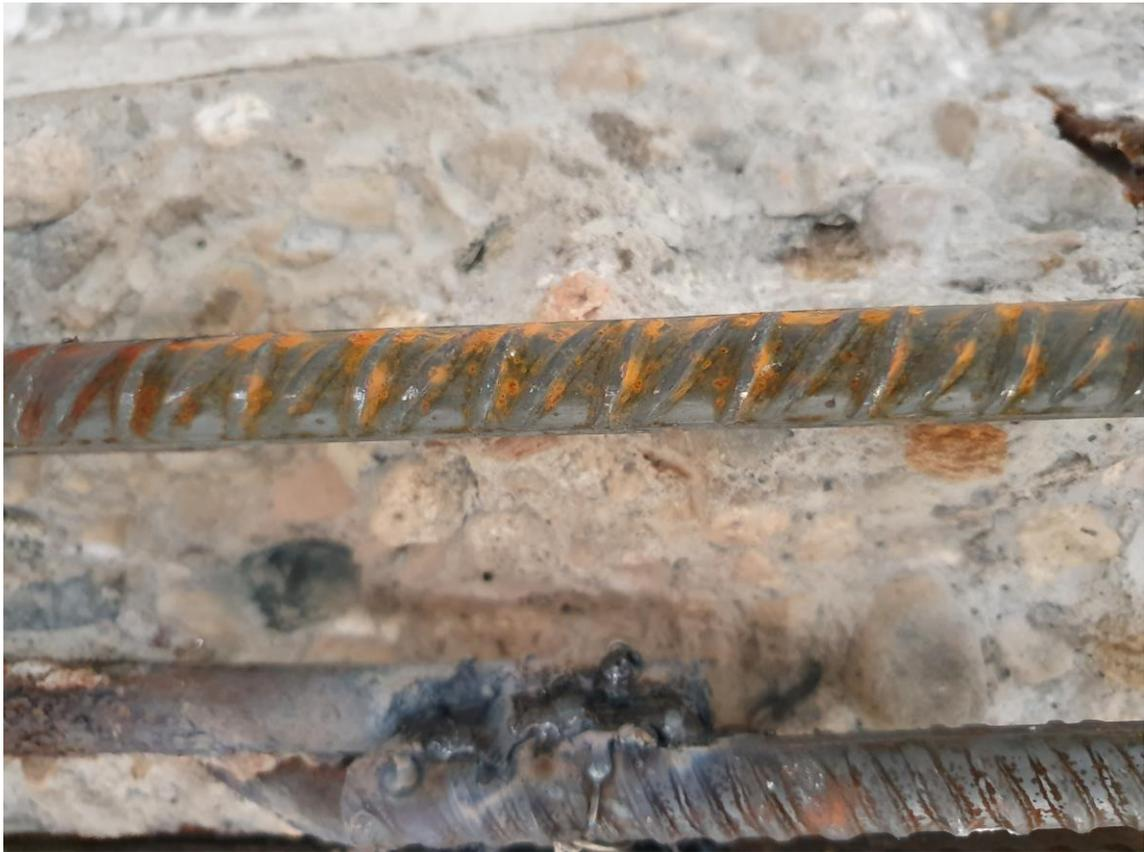
*Figura 13: Esempio di saldatura di una barra ripristinata*
