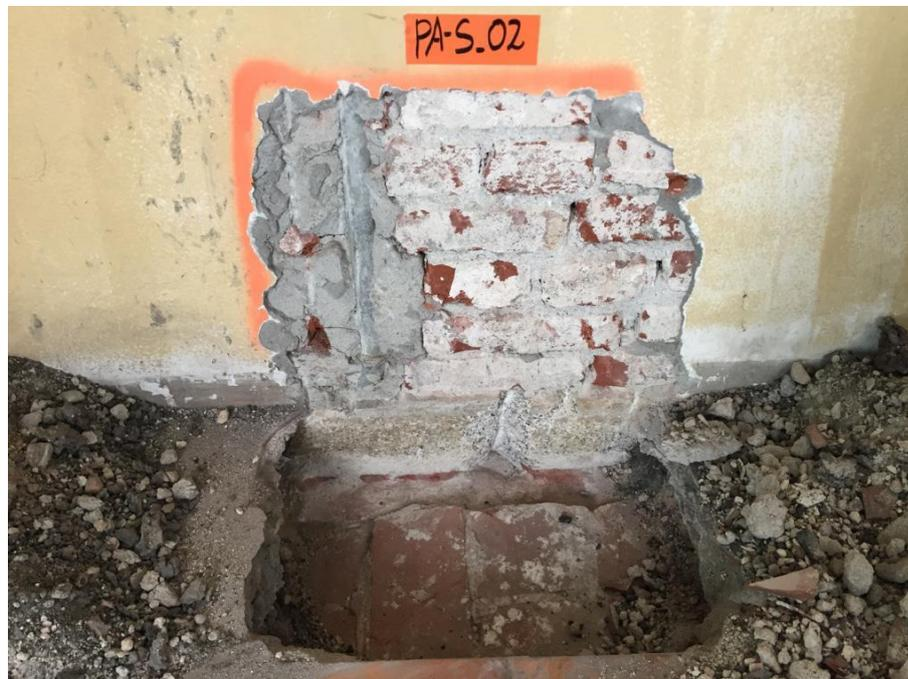
Figura 5: Esempio di scarifica, con identificazione dell'arco in mattoni e variazione di spessore della parete verticale
