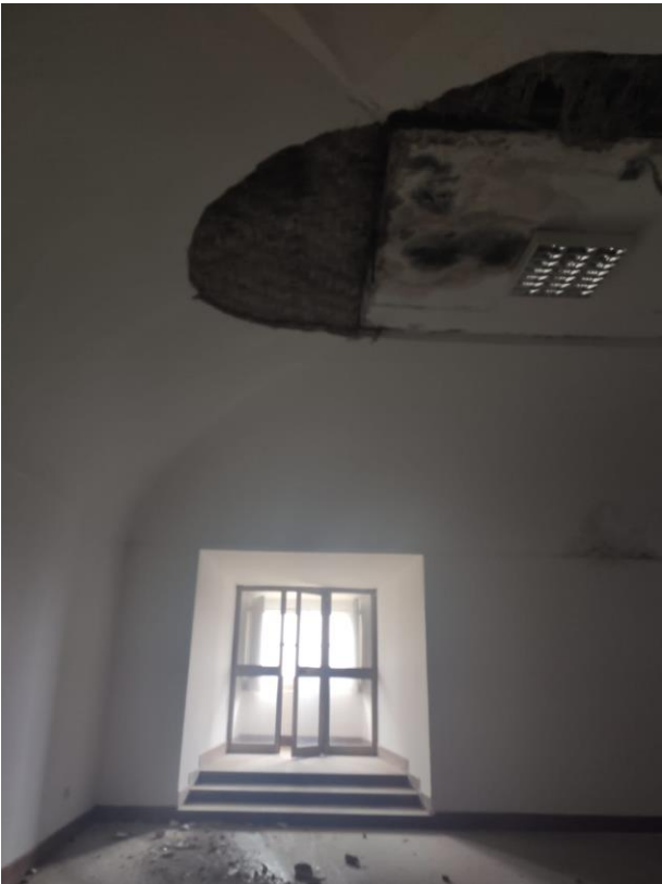
Piano Terzo_Lato Ovest
