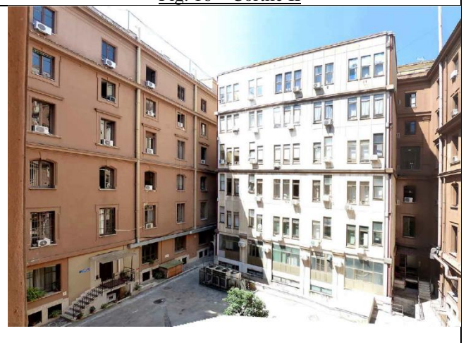
Fig. 18 – Corpo aggiunto cortile III
