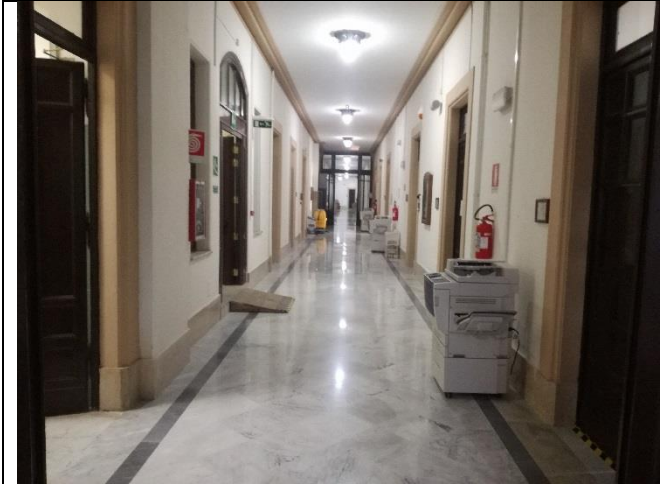
Fig. 23 – Disimpegno terzo piano
