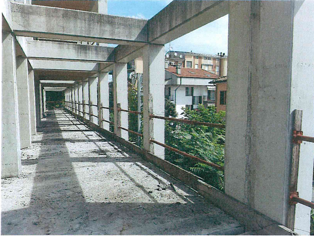
Fig.3: Parapetti piano quarto – lato su via Gramizzi
