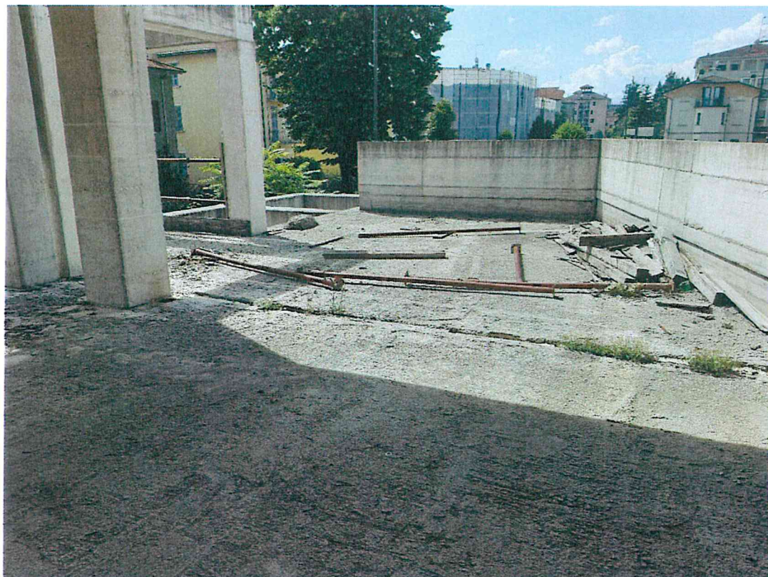
Fig.5: Terrazza di piano primo: si noti la presenza dei puntelli caduti
