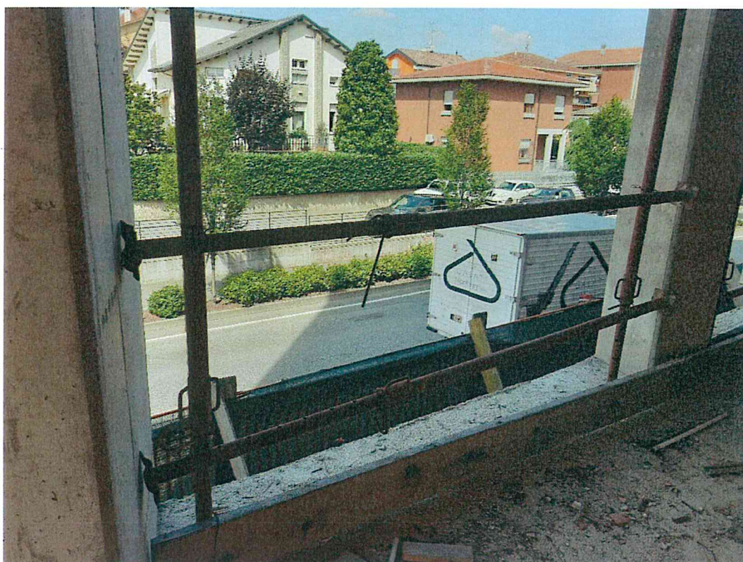
Fig.2: Parapetti piano primo
