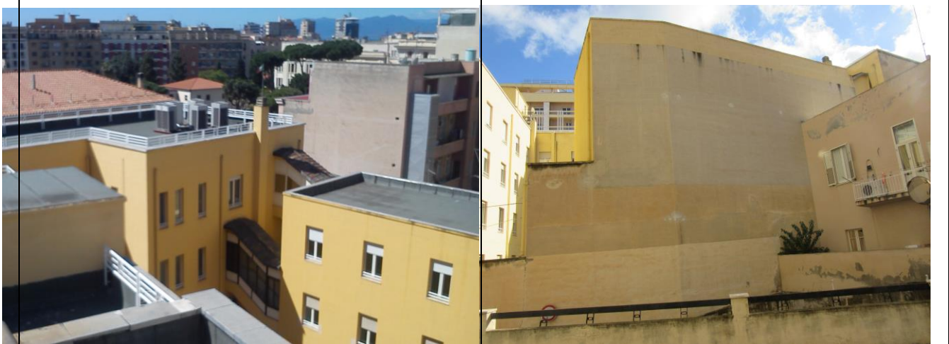
Fabbricato 2, fronte lato cortile interno e retro su proprietà privata confinante
