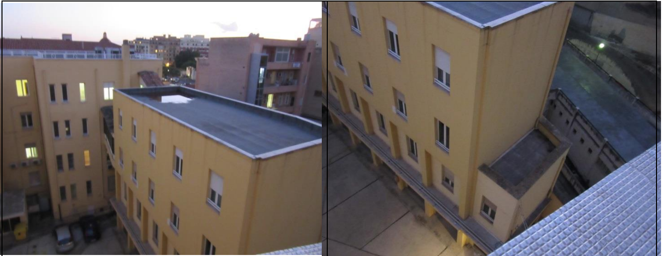
Copertura fabbricato 2 - CAB0551-FIP, Via Lo Frasso n.2.
