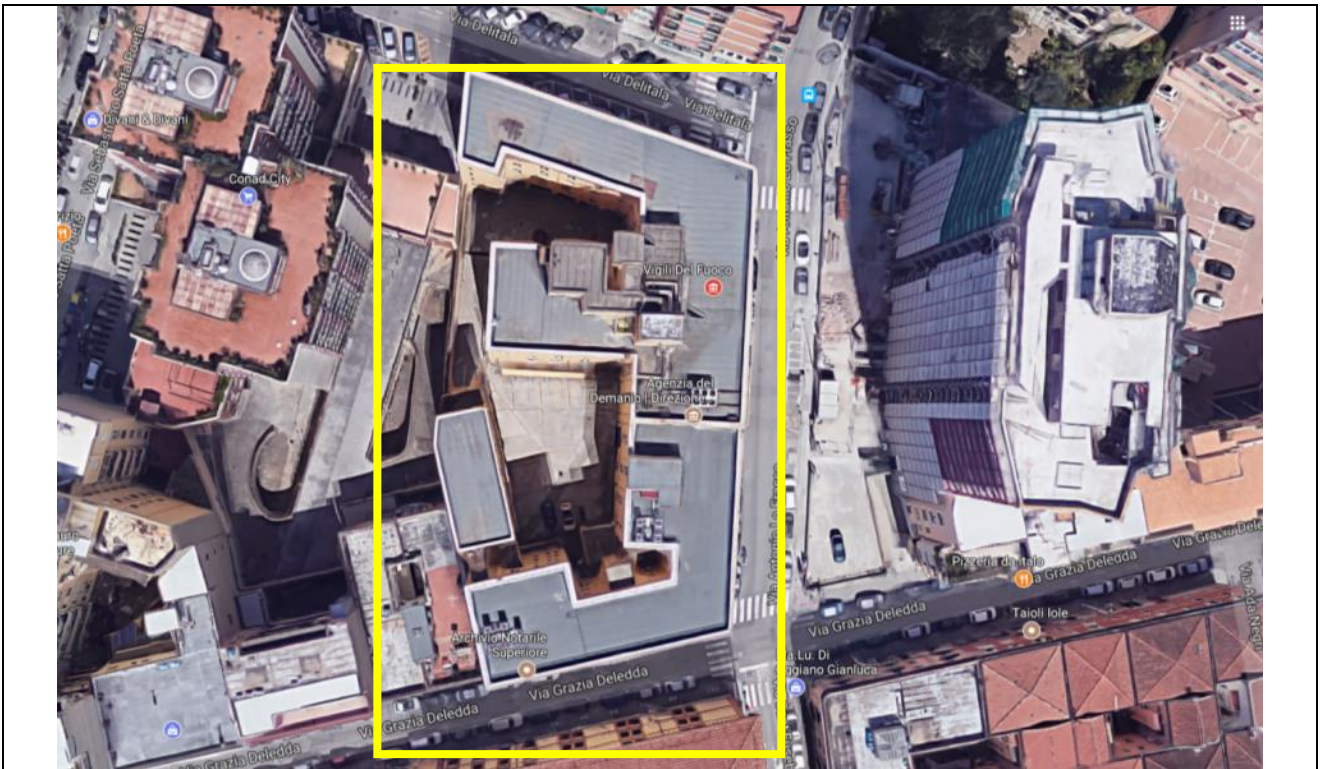
CAB0551-FIP, Via Deledda n.42 – Via Lo Frasso n.2. Ubicazione complesso in esame
