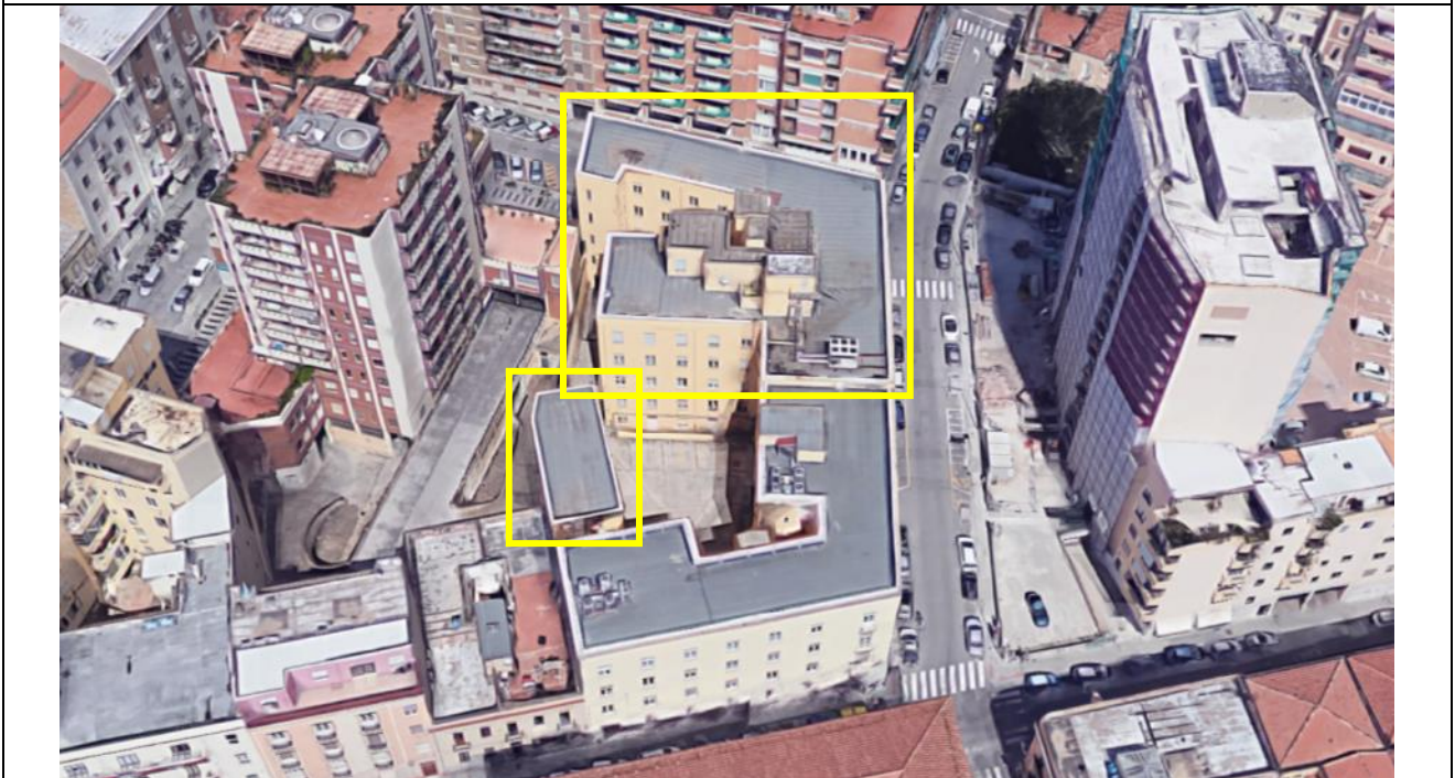
CAB0551-FIP, Via Deledda n.42 – Via Lo Frasso n.2. Coperture Fabbricati 2 e 3
