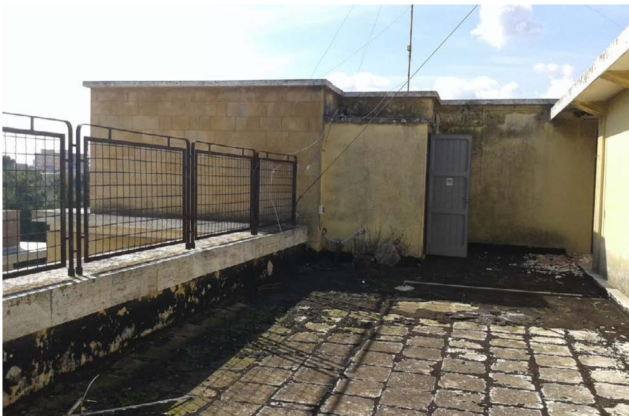
Foto 23 - Piano di copertura – Particolare vano ascensore e torrino scala
