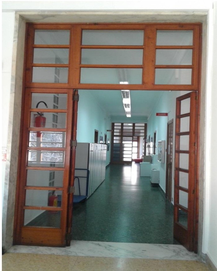
Foto 13 - Piano Primo – particolare ingresso corridoio
