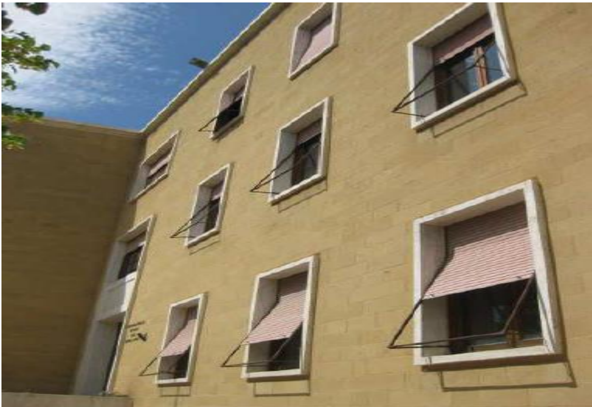
Foto 4 - Prospetto principale (sud)
