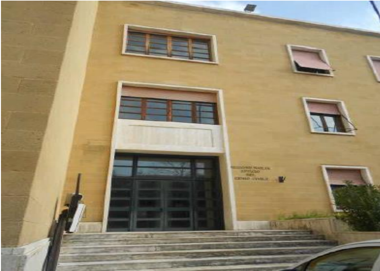
Foto 3 - Prospetto principale (sud)
