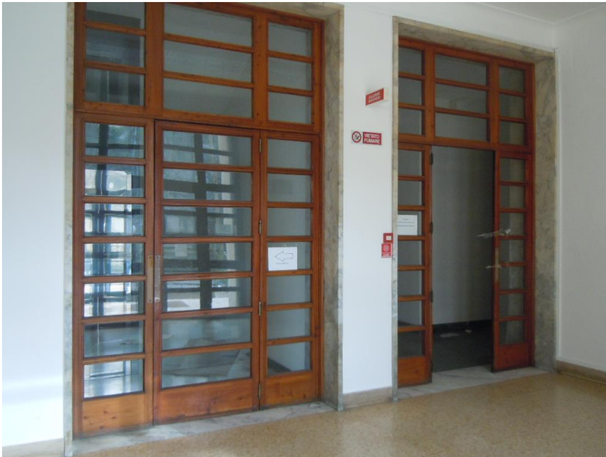
Foto 11 - Piano rialzato -Ingresso
