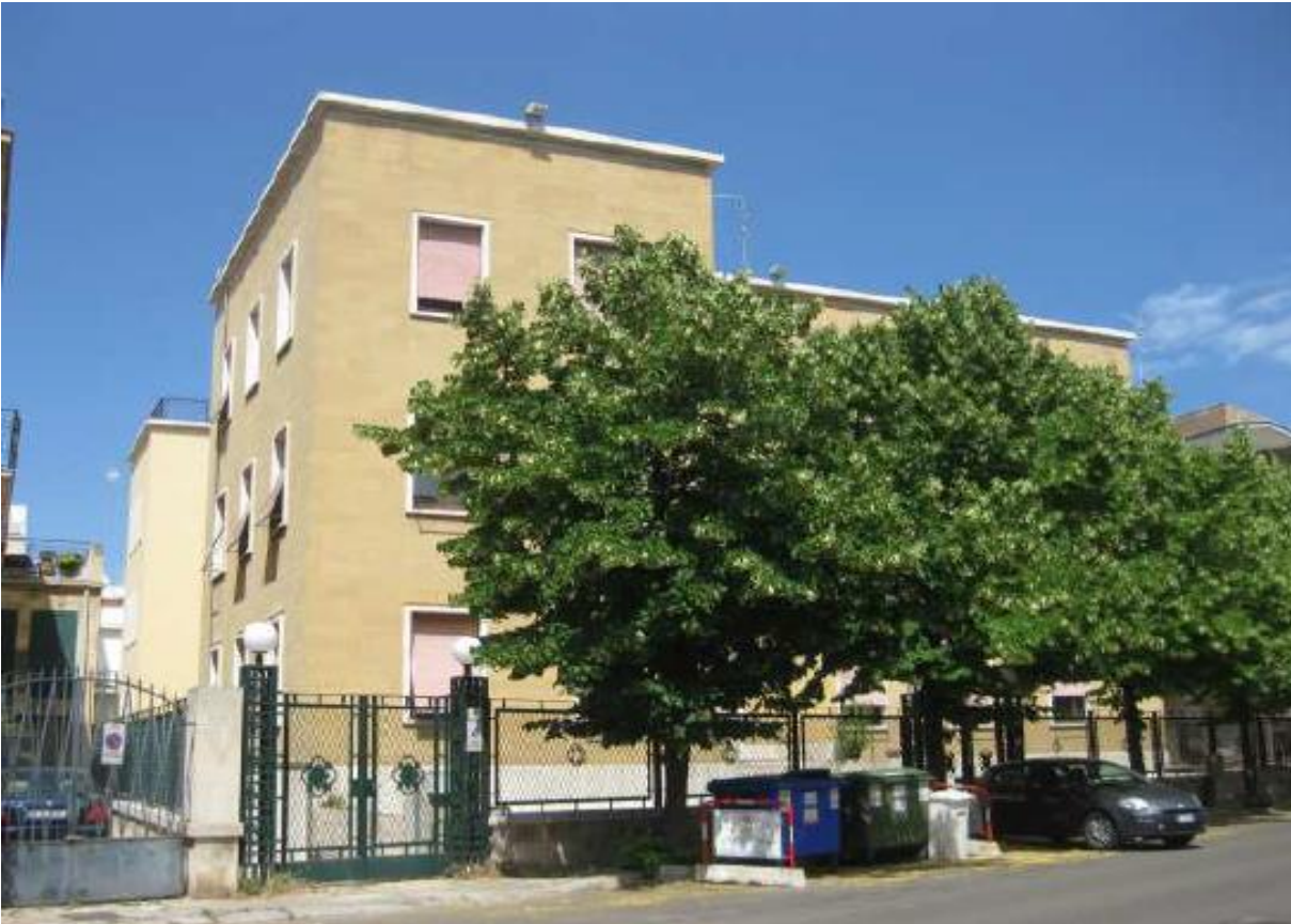
Foto 1 - Prospetto su via Don Minzoni
