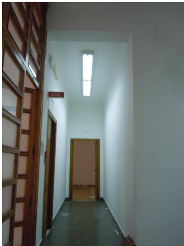
Foto 12 - Piano rialzato – particolare corridoio
