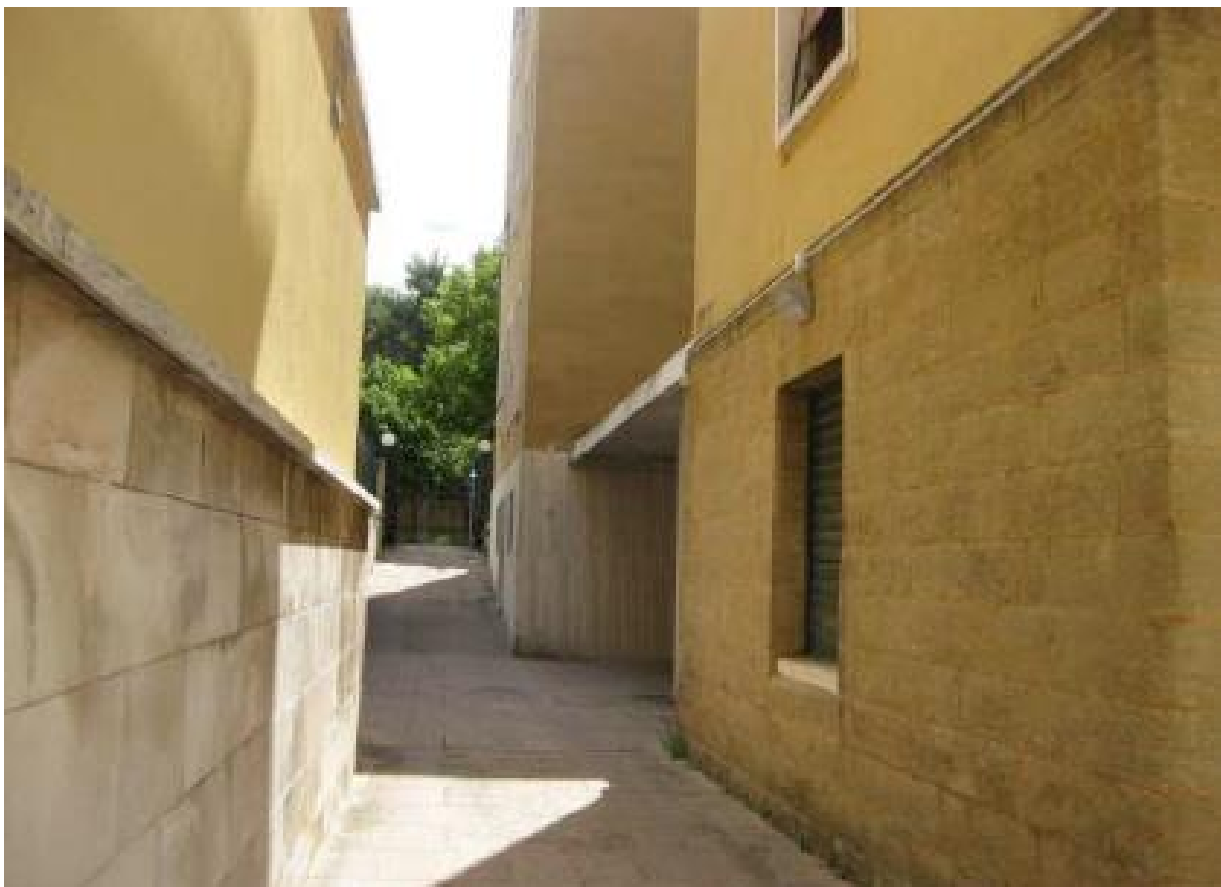
Foto 6 - Prospetto est, spazio di manovra
