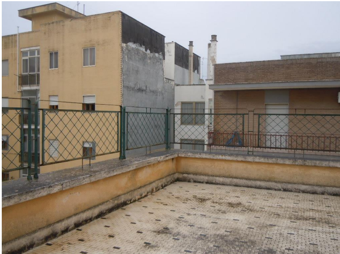
Foto 20 - Piano Secondo – particolare terrazza con vista dal piano di copertura
