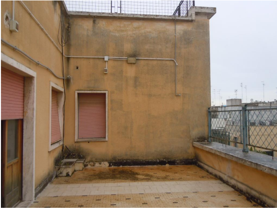
Foto 19 - Piano Secondo – particolare terrazza
