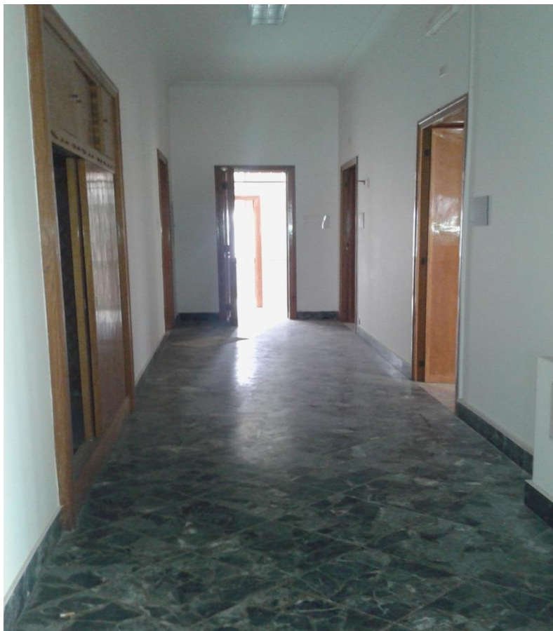
Foto 18 - Piano Secondo – particolare corridoio
