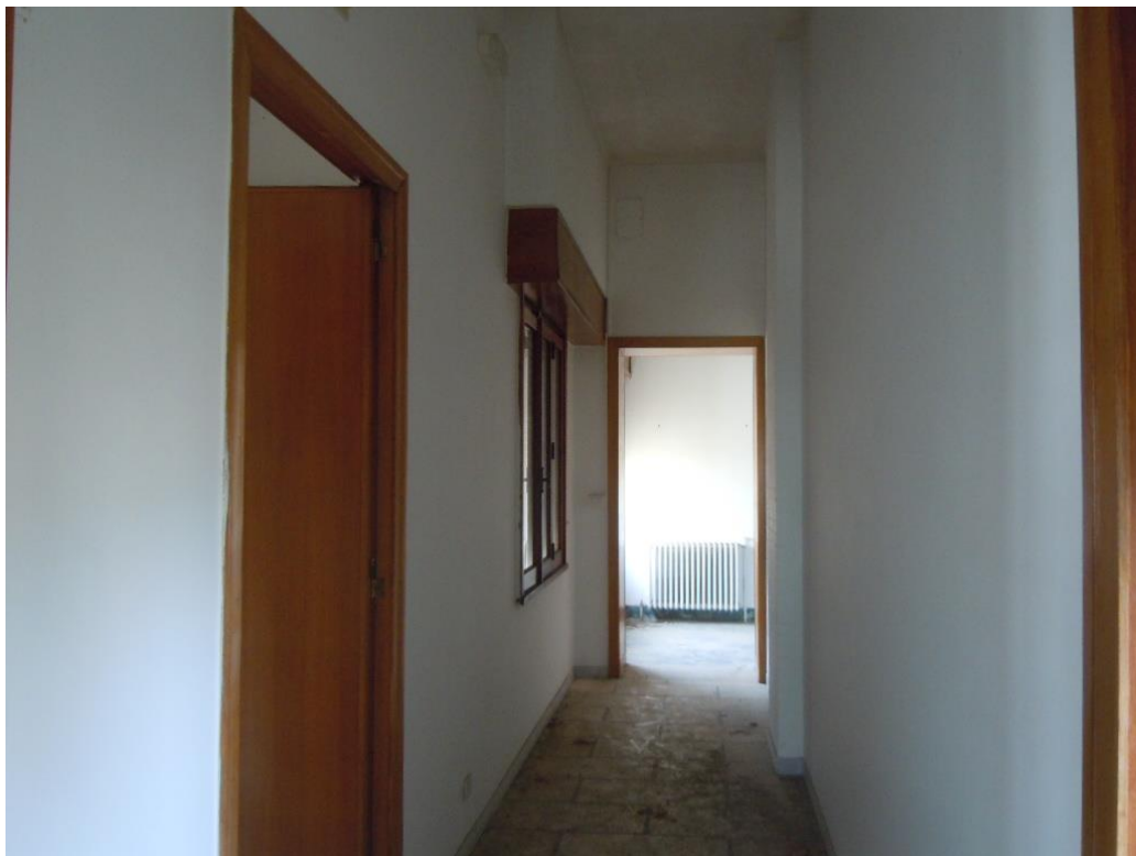
Foto 16 - Piano Secondo – particolare corridoio centrale
