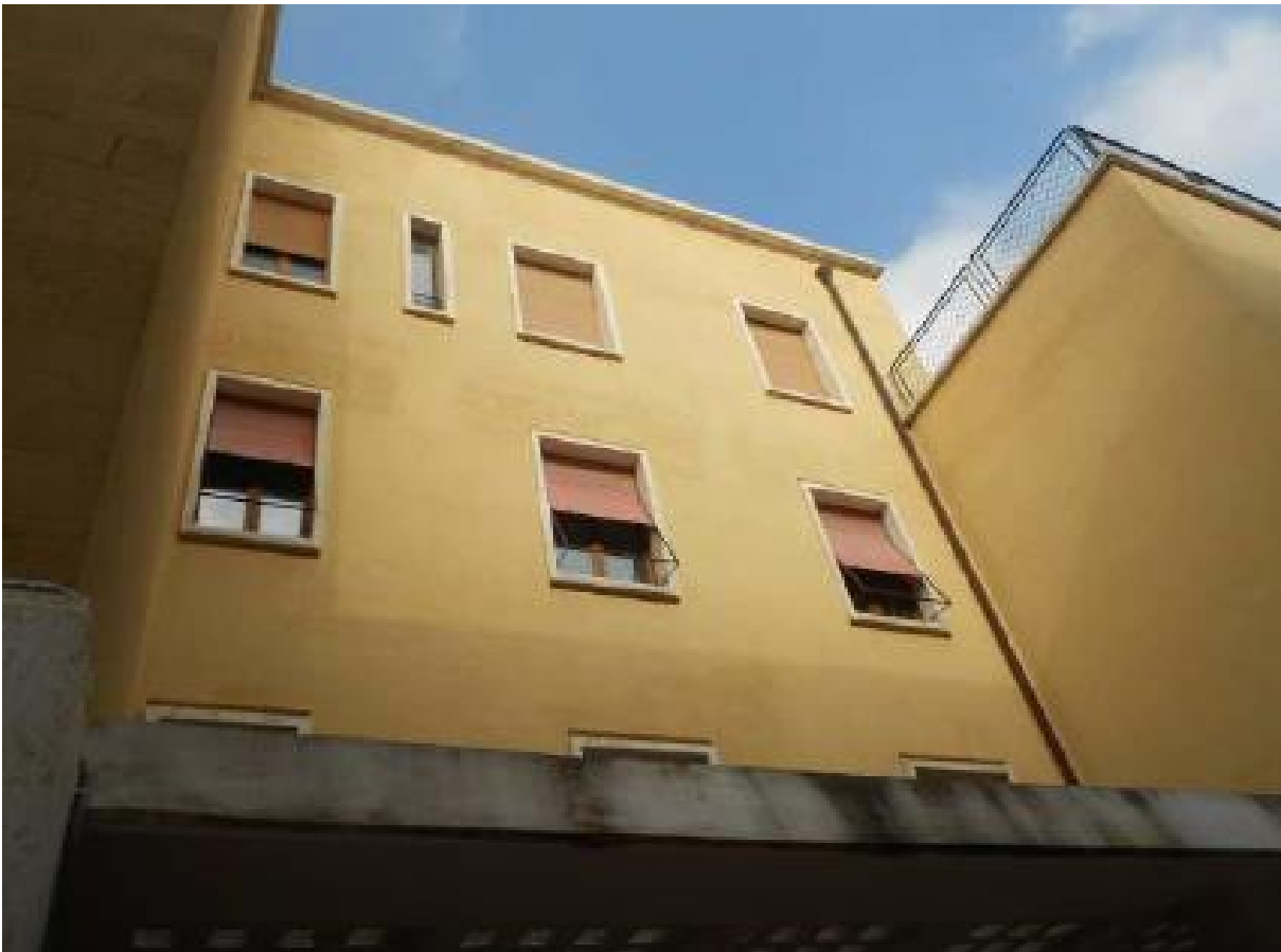
Foto 8 - Prospetto Est, con pensilina
